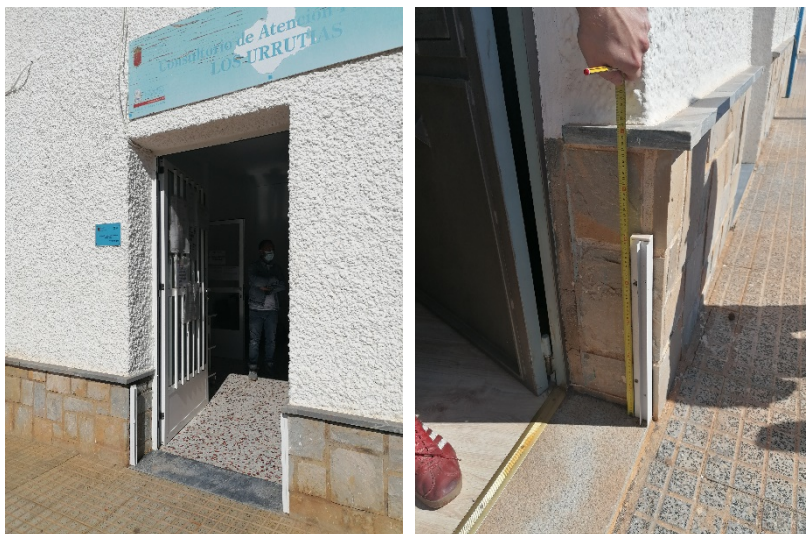
Figura 33. Protecciones temporales en puertas de acceso principal a consultorio y OMITA
