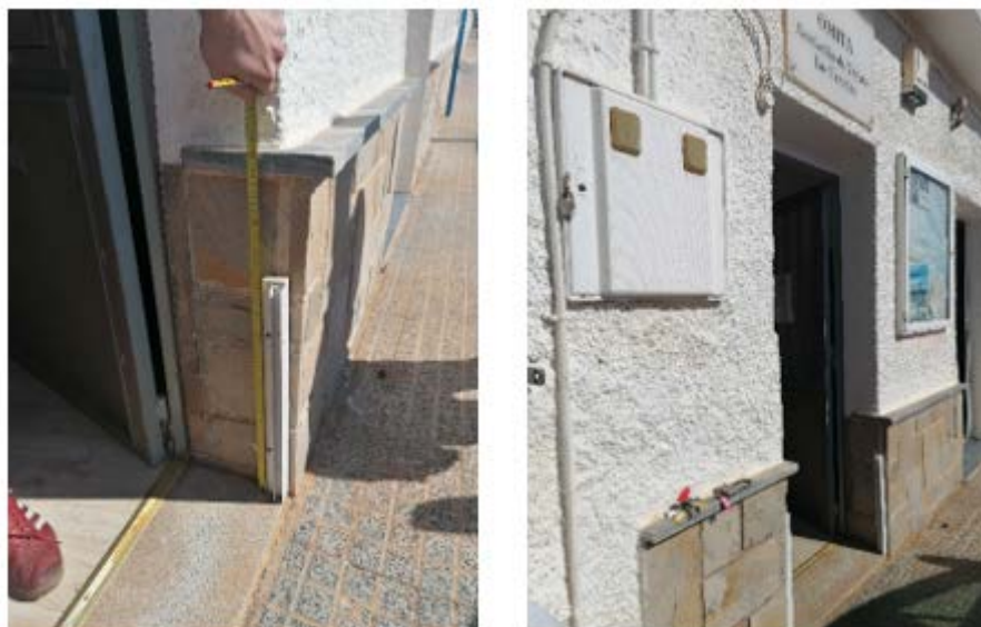
Figura 17. Puerta de acceso a OMITA. Sistema de protección frente a inundaciones
