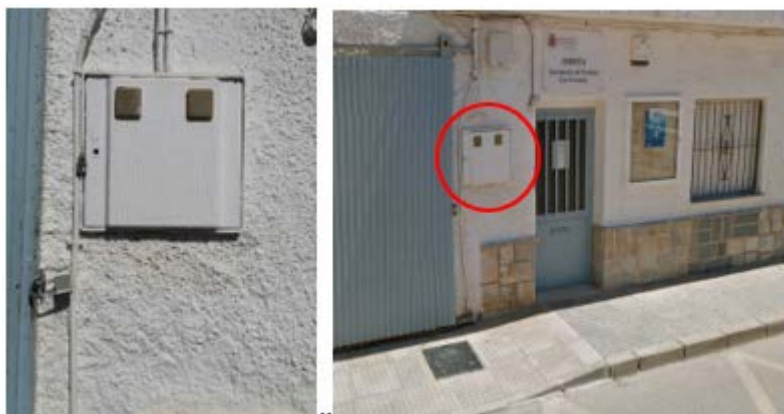
Figura 24. Acometida general de electricidad junto a la puerta de la OMITA, en la calle Ramos Carratalá
