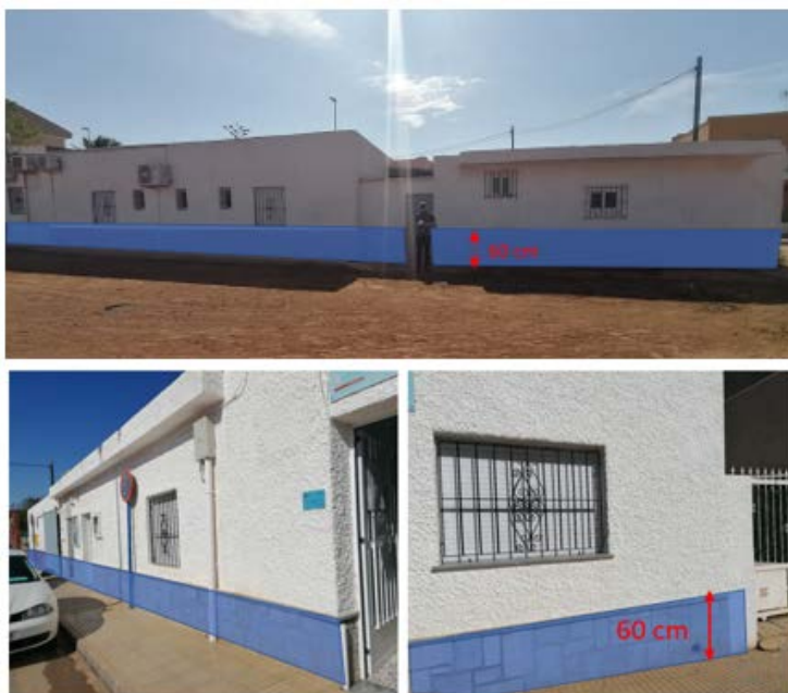
Figura 35. Impermeabilización de fachada
