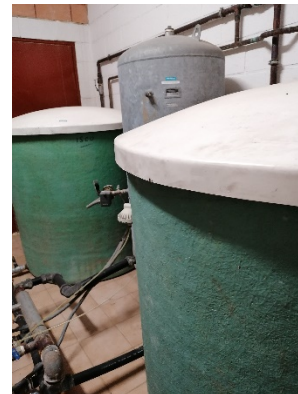
Sala de calderas, dos depósitos de agua, sistemas de inercia. Acumuladores
