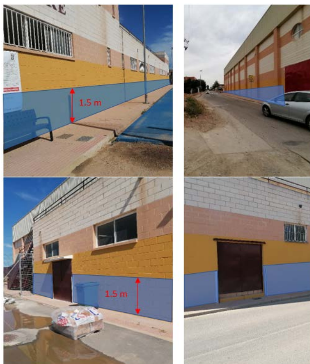
Figura 45. Impermeabilización de fachada
