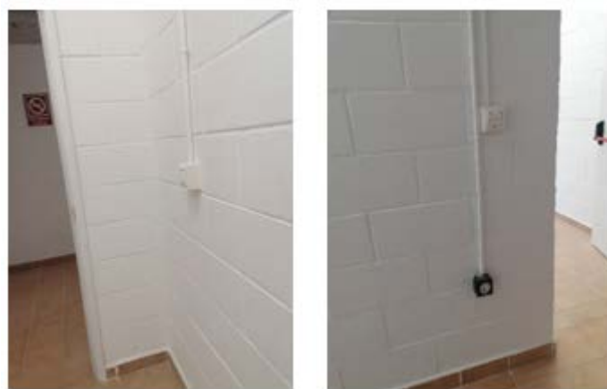
Figura 32. Interruptores elevados/tomas eléctricas no elevadas
