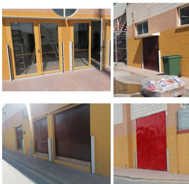
Figura 39. Puertas con soportes para colocación de barreras anti-inundaciones
