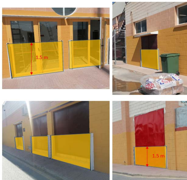
Figura 46. Disposición de puertas metálicas desmontables
