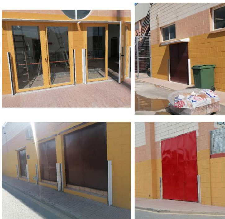
Figura 42. Puertas con soportes para colocación de barreras anti-inundaciones
