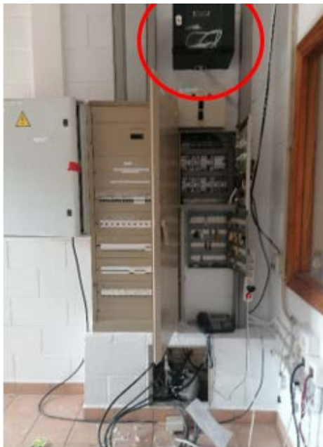
Figura 35. Sistema de comunicaciones elevado
