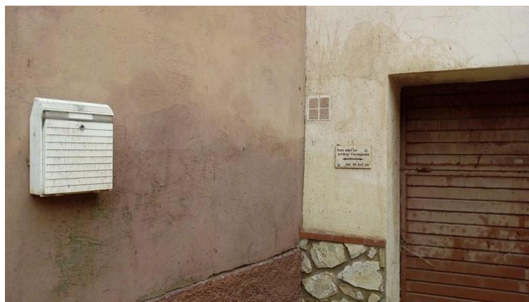
Fotografía 4. Río Francolí, nivel alcanzado del agua en la plaza del Pont en comparación a la del año 1994, aproximadamente unos 20 cm superiores. TM La Riba.
