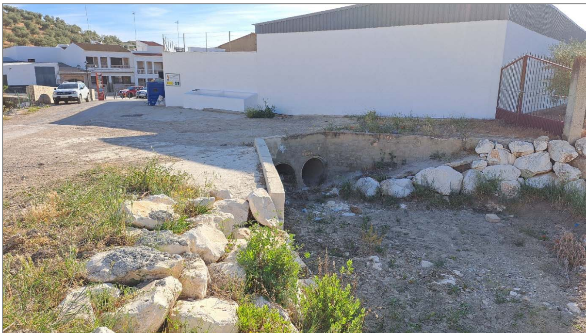
Fotografía 7: Inicio del soterramiento del ramal oeste del Ballesteros bajo Algámitas
