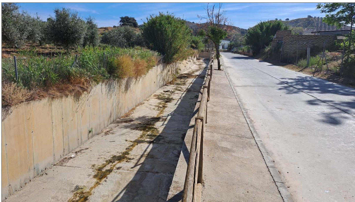
Fotografía 24: THMF 2: Canal hormigonado
