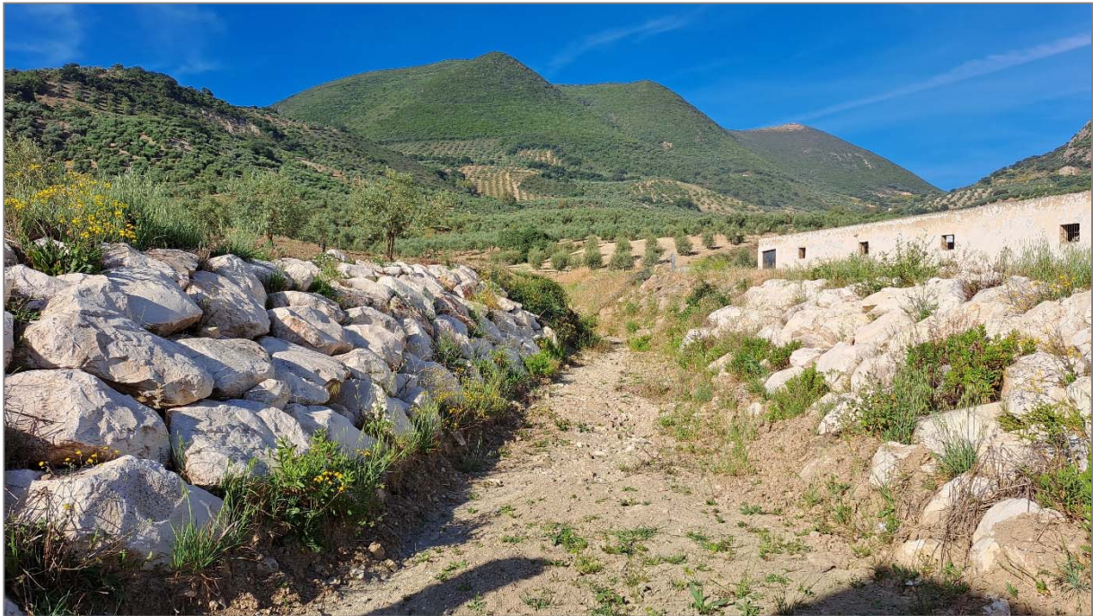
Fotografía 11: Protección de taludes mediante escollera colocada
