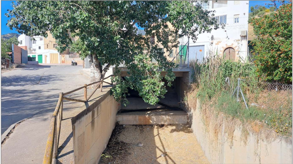
Fotografía 19: Salida del tramo soterrado a canal hormigonado
