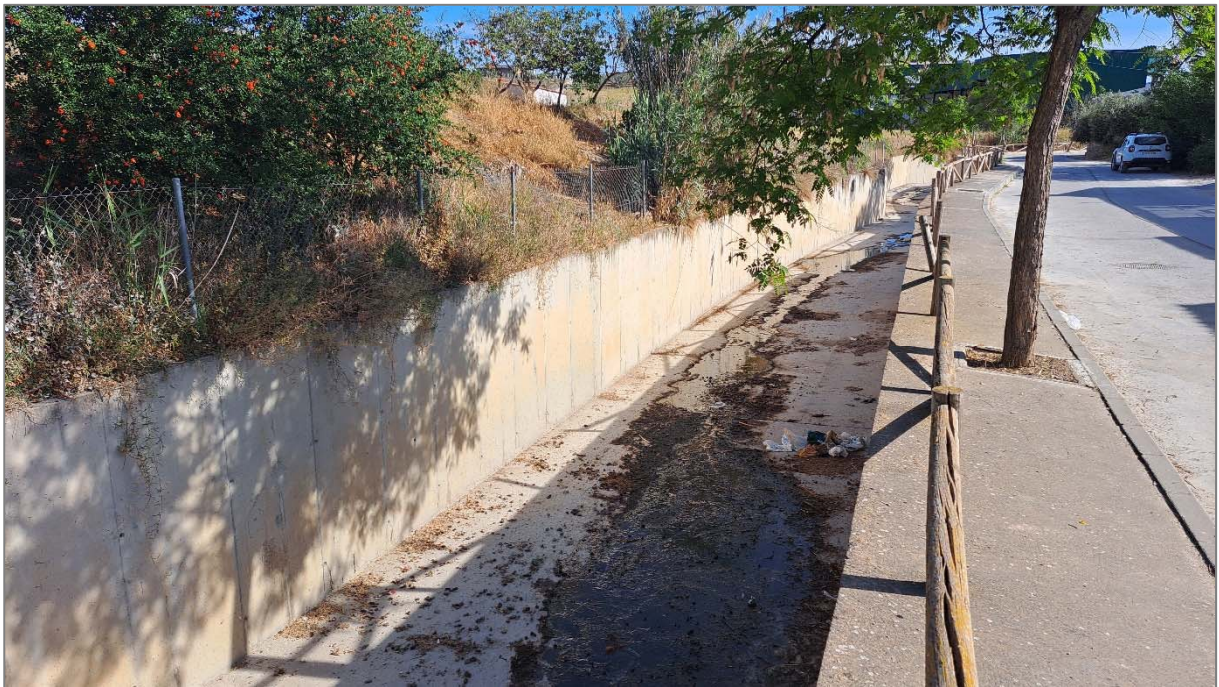
Fotografía 20: Canal hormigonado
