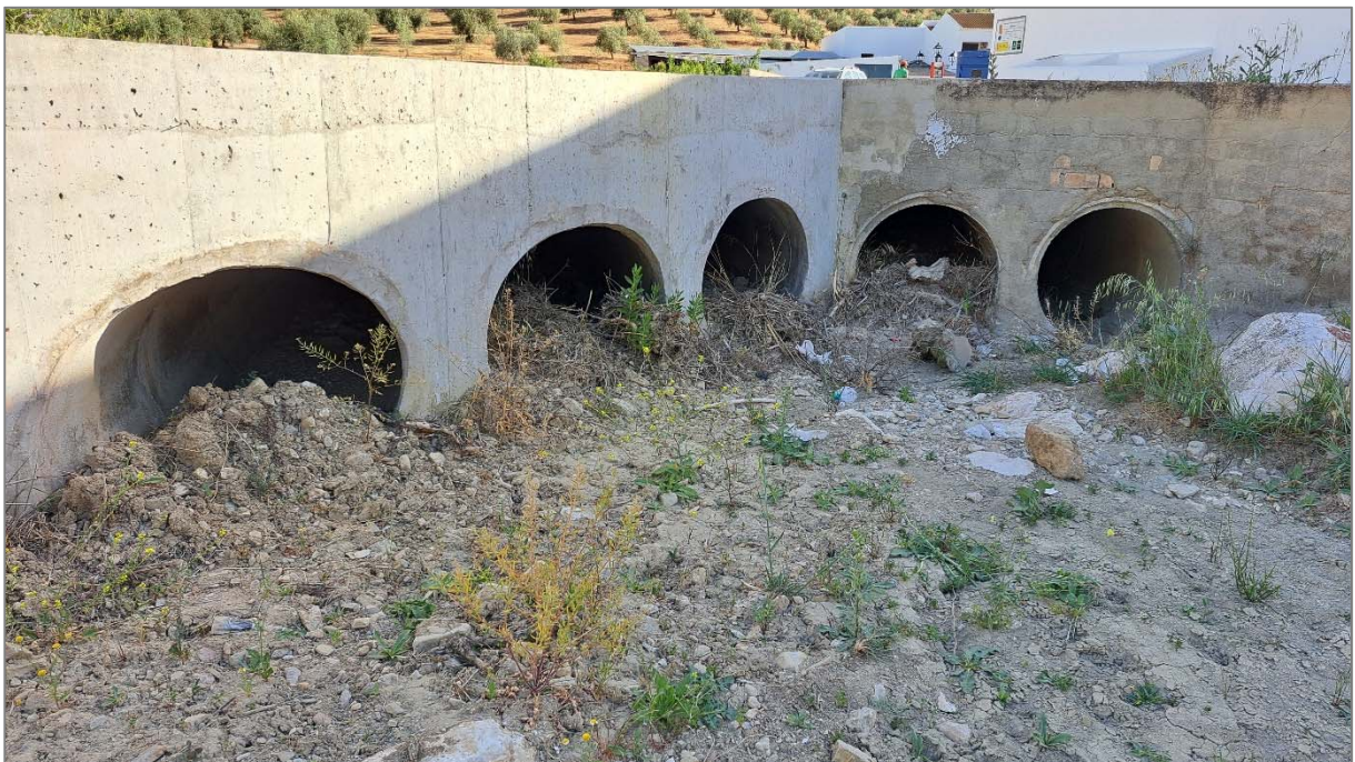
Fotografía 10: Soterramiento del arroyo bajo Algámitas
