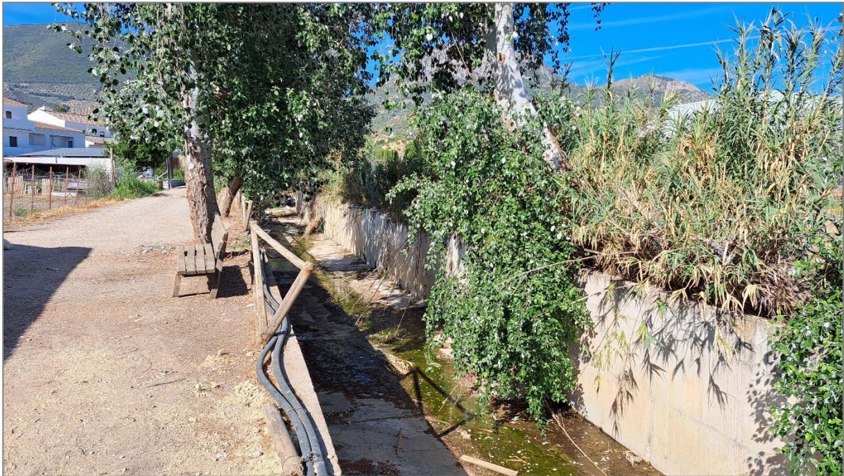
Fotografía 25: Canal hormigonado
