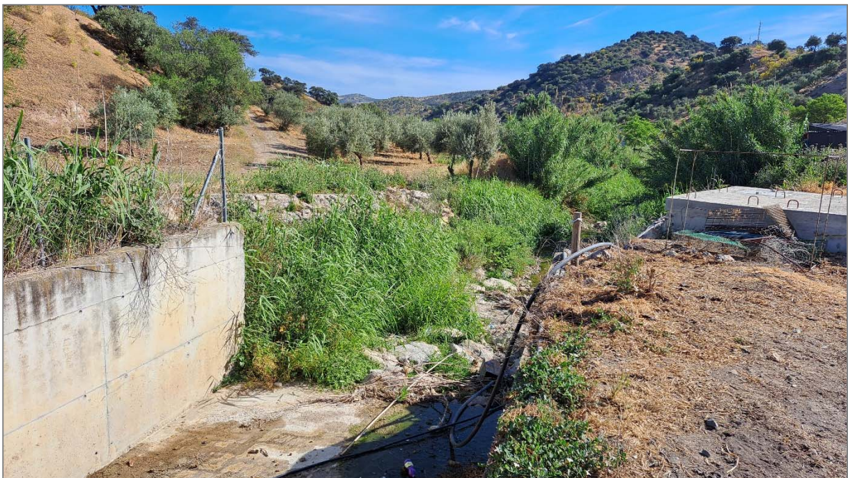
Fotografía 26: Transición del tramo encauzado con el tramo estrechado
