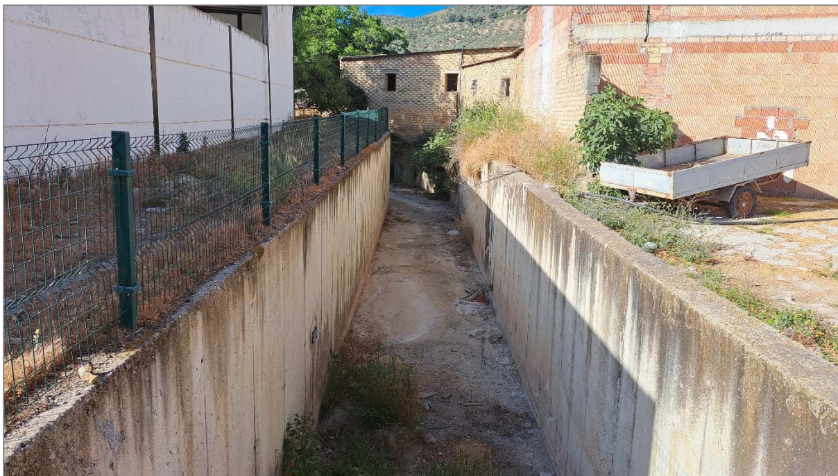
Fotografía 17: Tramo del arroyo Ballesteros encauzado en inicio del soterramiento del ramal este
