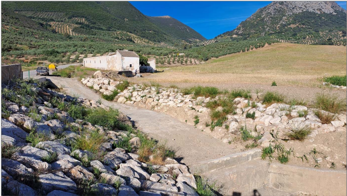
Fotografía 5: Encauzamiento con escollera
