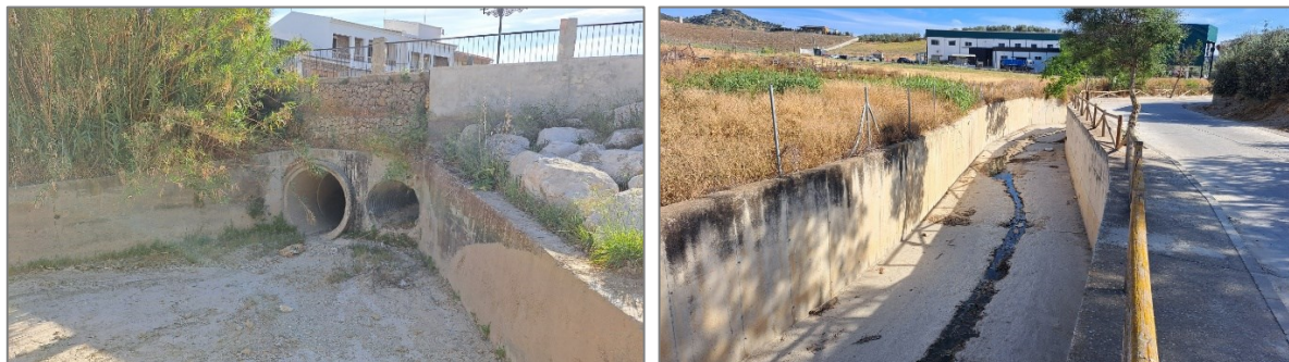
Fotografía 2.- Soterramiento y encauzamiento del arroyo Los Ballesteros a su paso por Algámitas.
