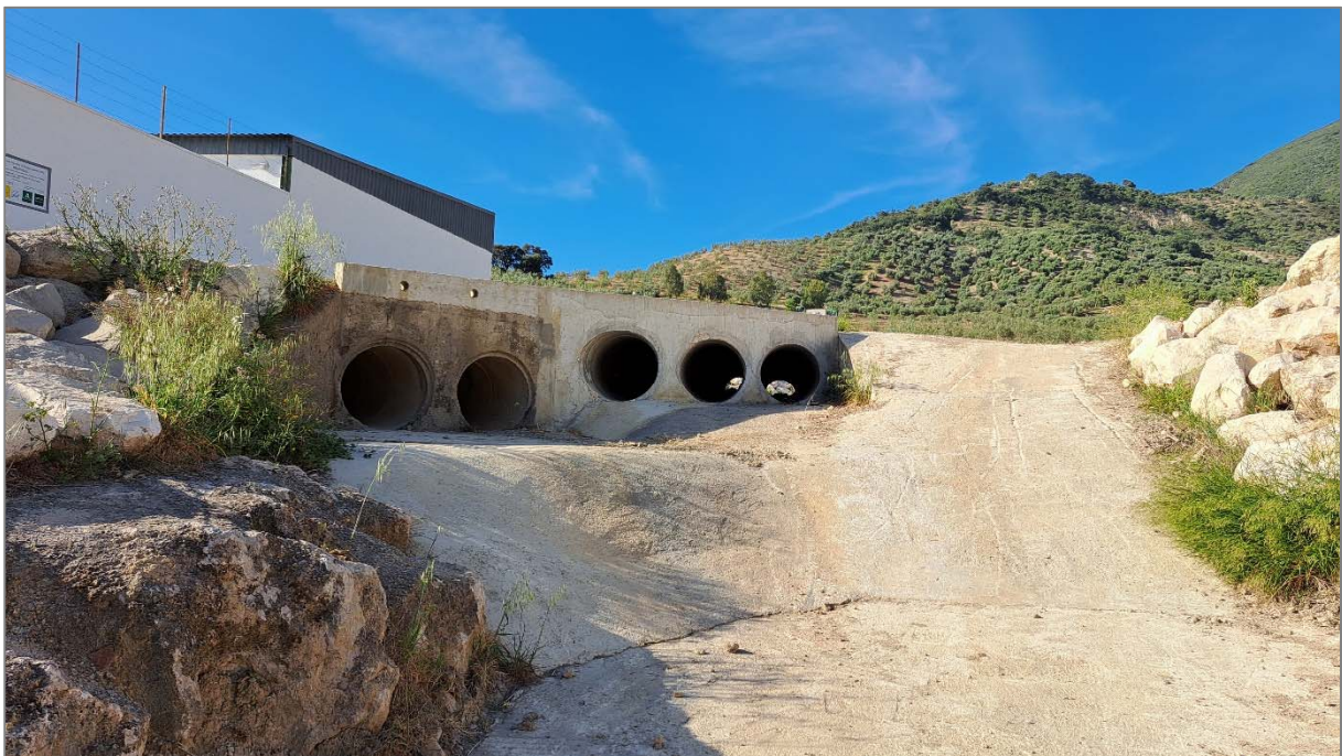
Fotografía 12: Transición del canal a cielo abierto con los tramos soterrados
