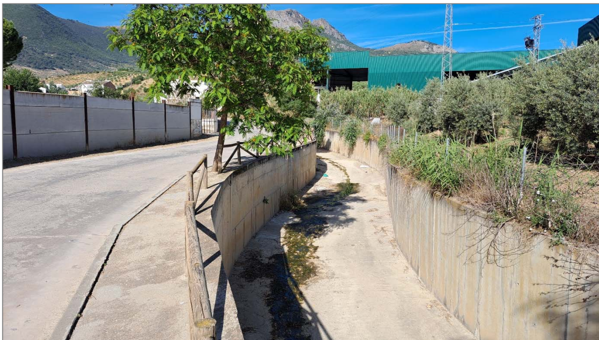
Fotografía 23: THMF 2: Canal hormigonado
