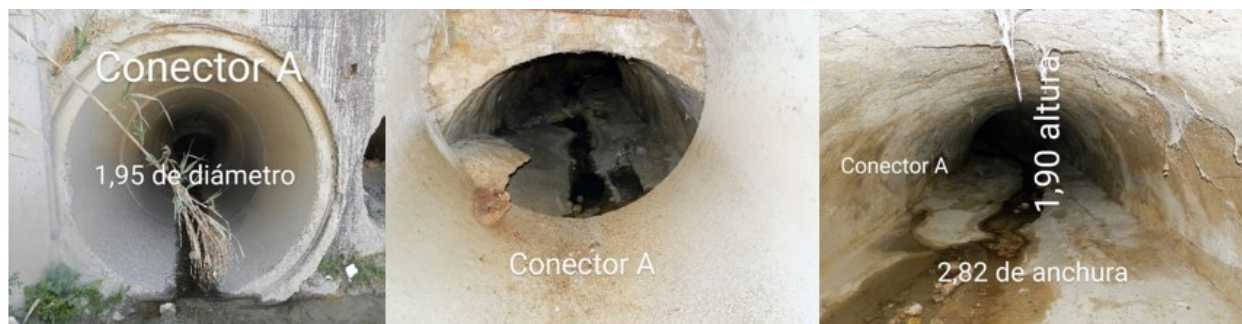
Figura 8: Transición entre las dos conducciones. Fuente: Ayuntamiento de Algámitas
