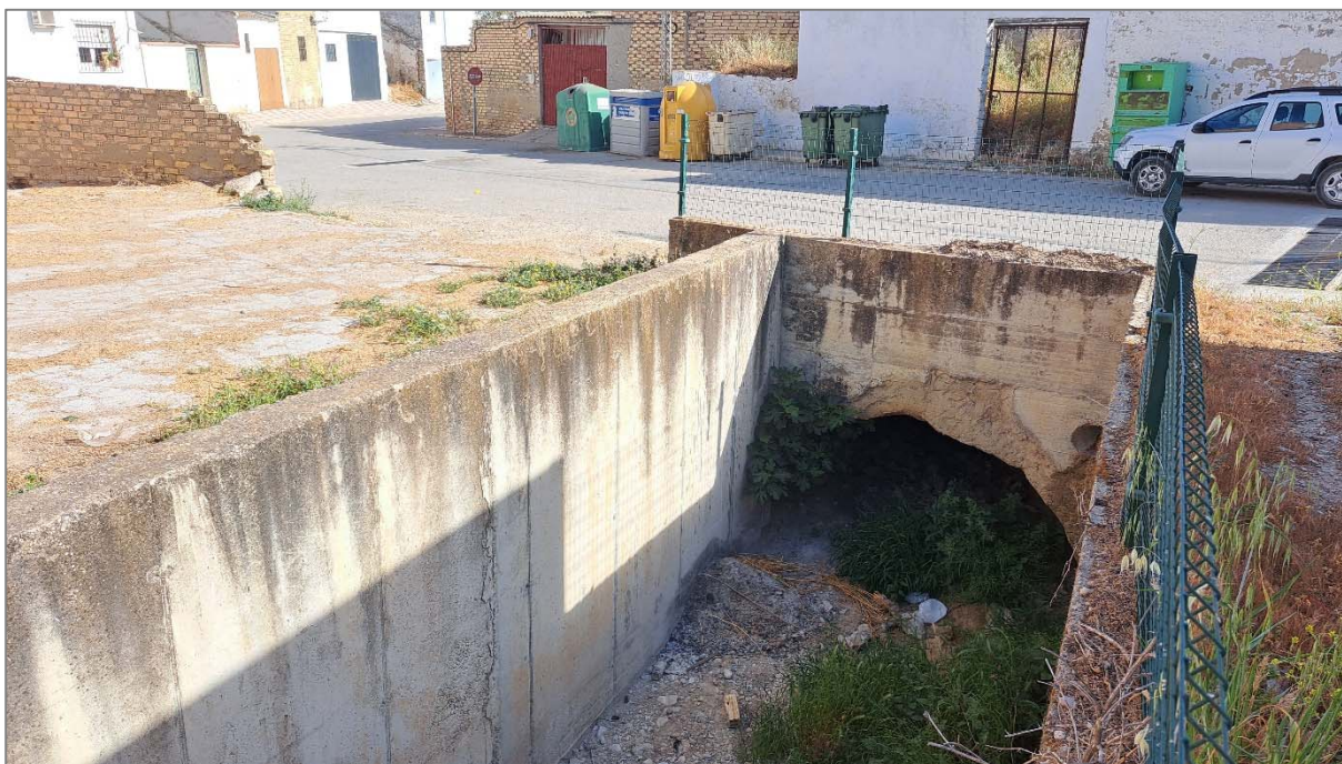
Fotografía 18: Soterramiento del ramal este del arroyo Ballesteros
