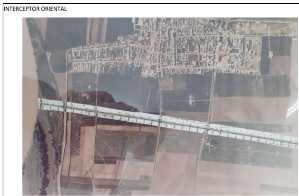
Figura 6. Imagen del interceptor oriental que el Ayuntamiento de Villaverde del Río adjunta en la ficha de actuaciones enviada durante la consulta pública del PGRI del Guadalquivir de 2º ciclo.
