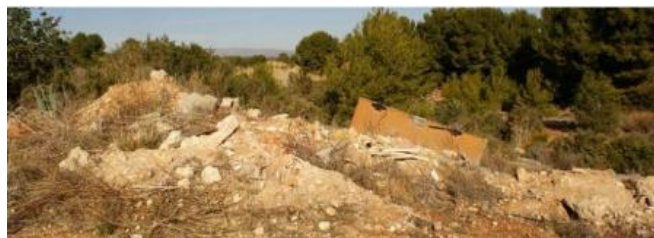
Figura 8. Restos de construcción acumulados en el cauce del barranco
