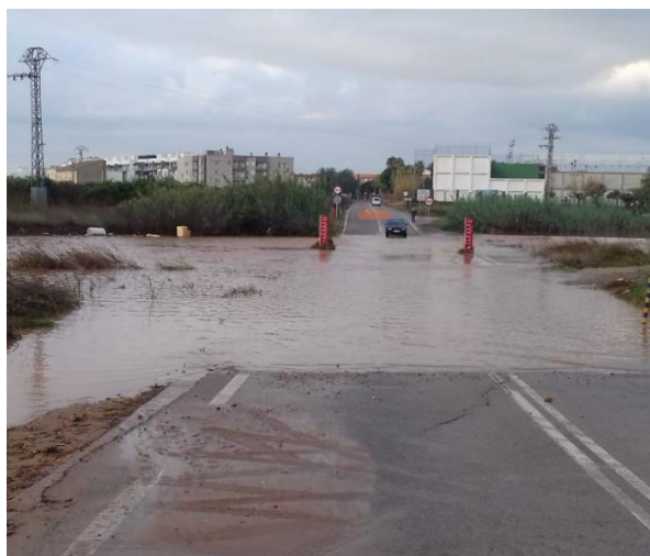
Figura 2. Imagen del badén de la CV-304 en el cruce con el barranco de Carraixet. Fuente: Gent de l'Horta
