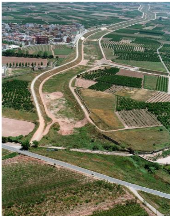
Figura 9. Tramo final de la FASE I ya ejecutada e inicio de la FASE II
