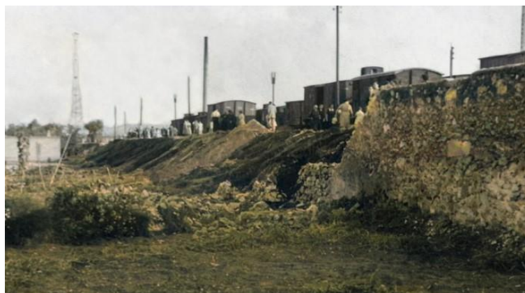
Figura 2 Muro derribado con la riada de 1955 entre la estación de ferrocarril y las viviendas.
