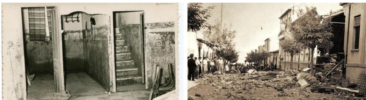
Figura 7. Daños en las casas que quedaron inundadas tras la avenida de 1955.
