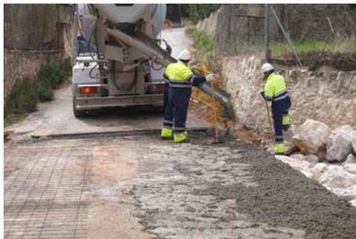
Figura 9. Obras en la rambla en 2016.
