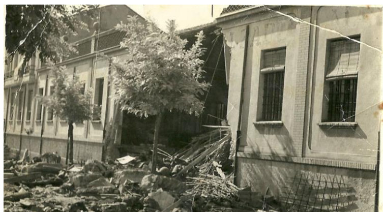
Figura 3 Destrozos en la fábrica de Almodóvar por la fuerza del agua.
