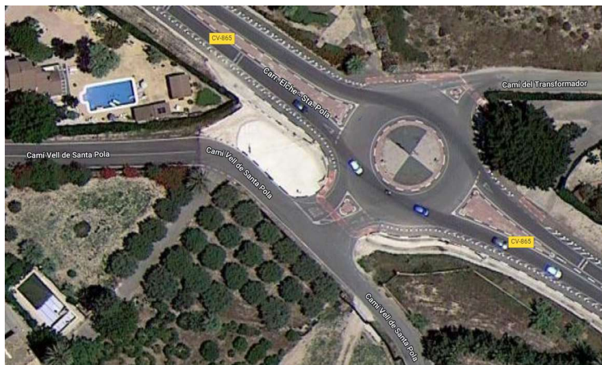
Figura 3. Obras para captación de las escorrentías de Camí Vell de Santa Pola y la CV-865
