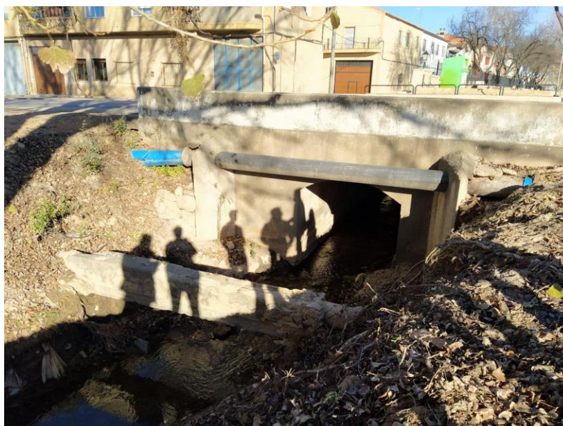
Figura 9. Obra de paso bajo la CM-311, cauce soterrado de la cañada del Monegrillo
