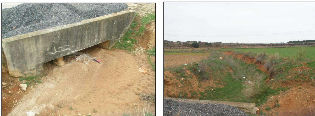
Figura 4. Situación antes de la actuación
