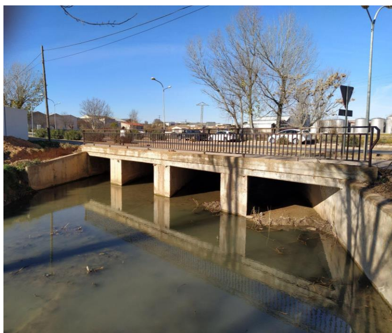
Figura 10. Obra de paso bajo la CM-3116
