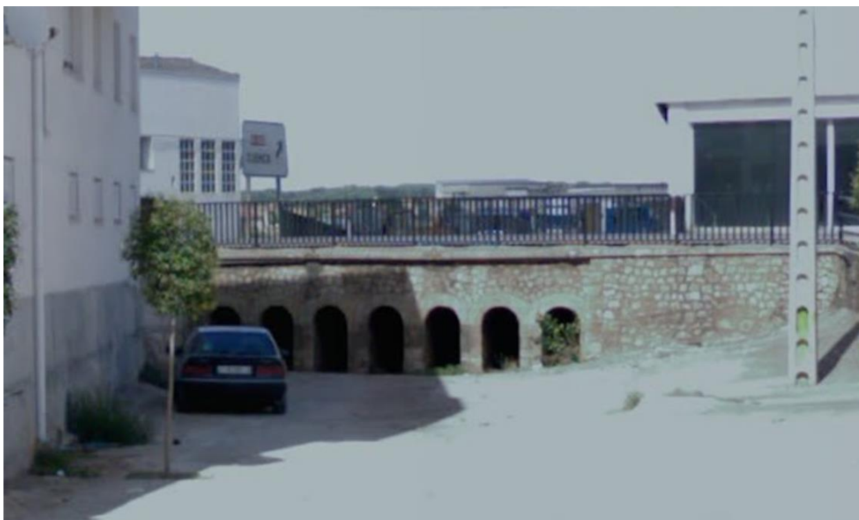
Figura 5. Puente de la N-III sobre la rambla del Riato
