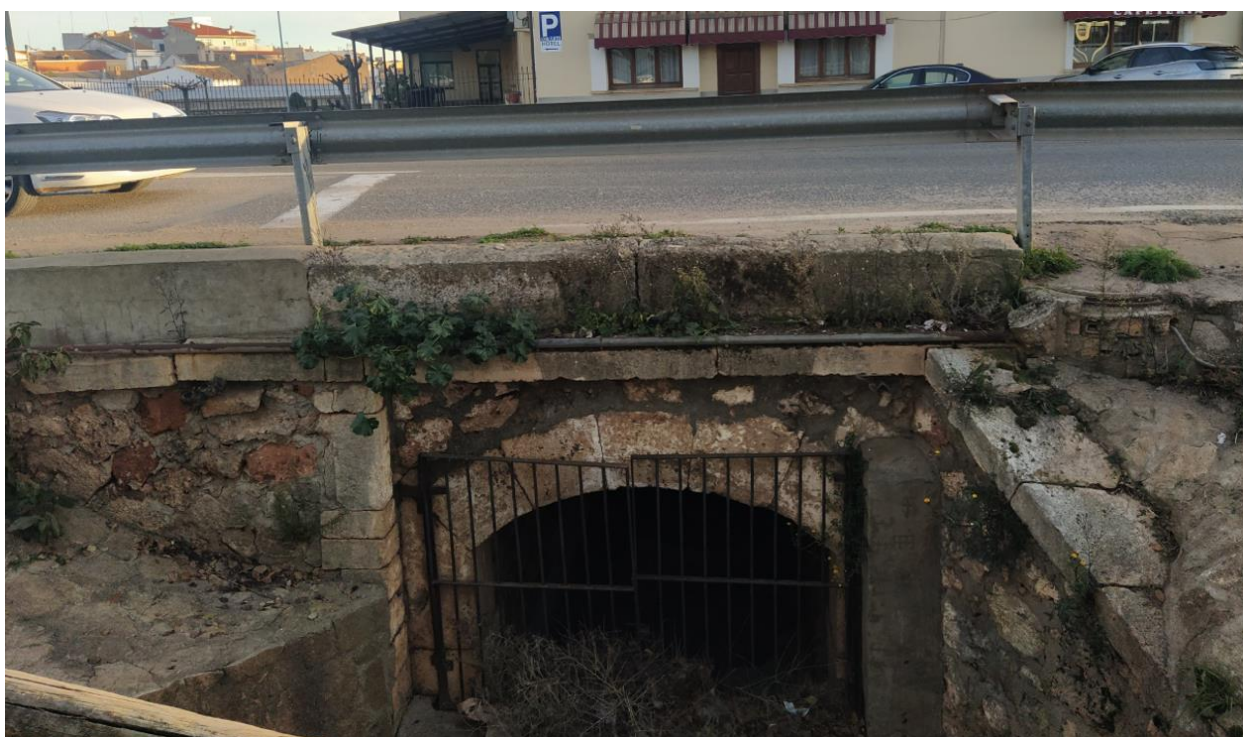
Figura 6. Obra de paso bajo la N-III y hotel del Sol
