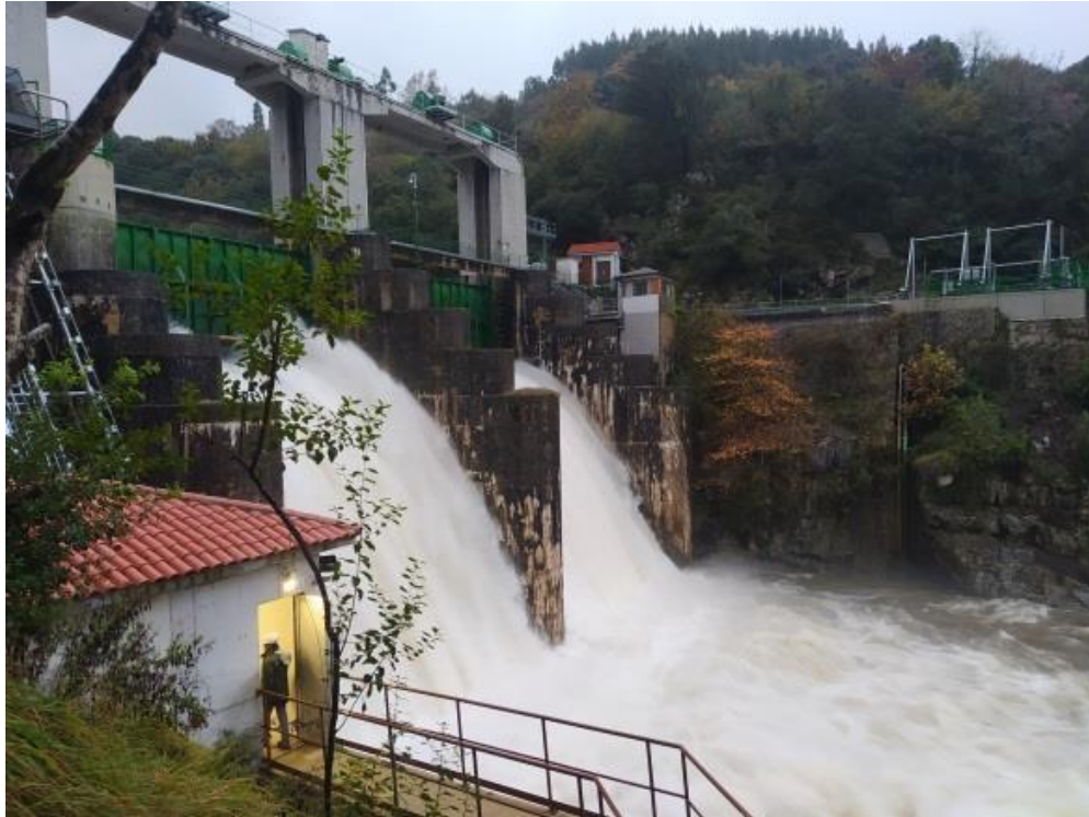
Presa de Palombera en el río Nansa (Cantabria).
