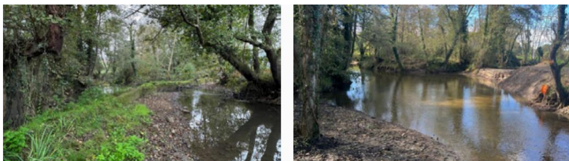
Demolición azud río Nora en Meres, Siero (Asturias)
