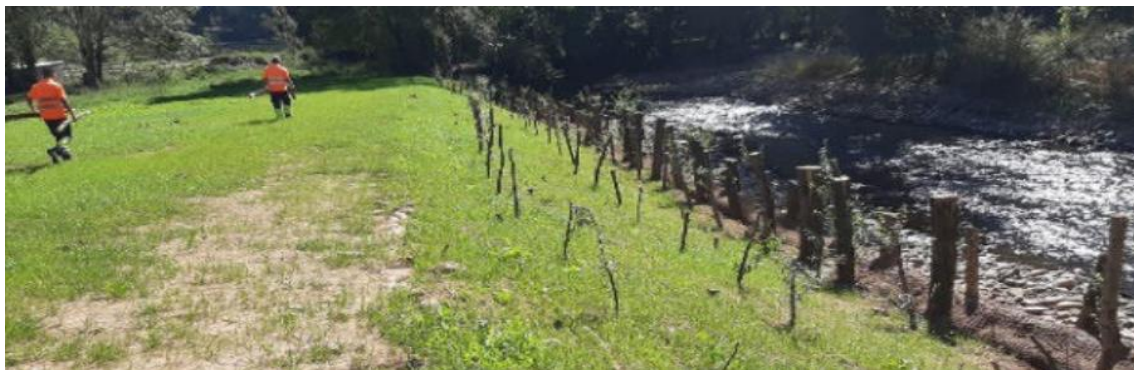
Recuperación de orilla erosionada y de la vegetación de ribera. Río Pisueña en Bº Hoz, T.M. SANTA MARÍA DE CAYÓN (Cantabria)
