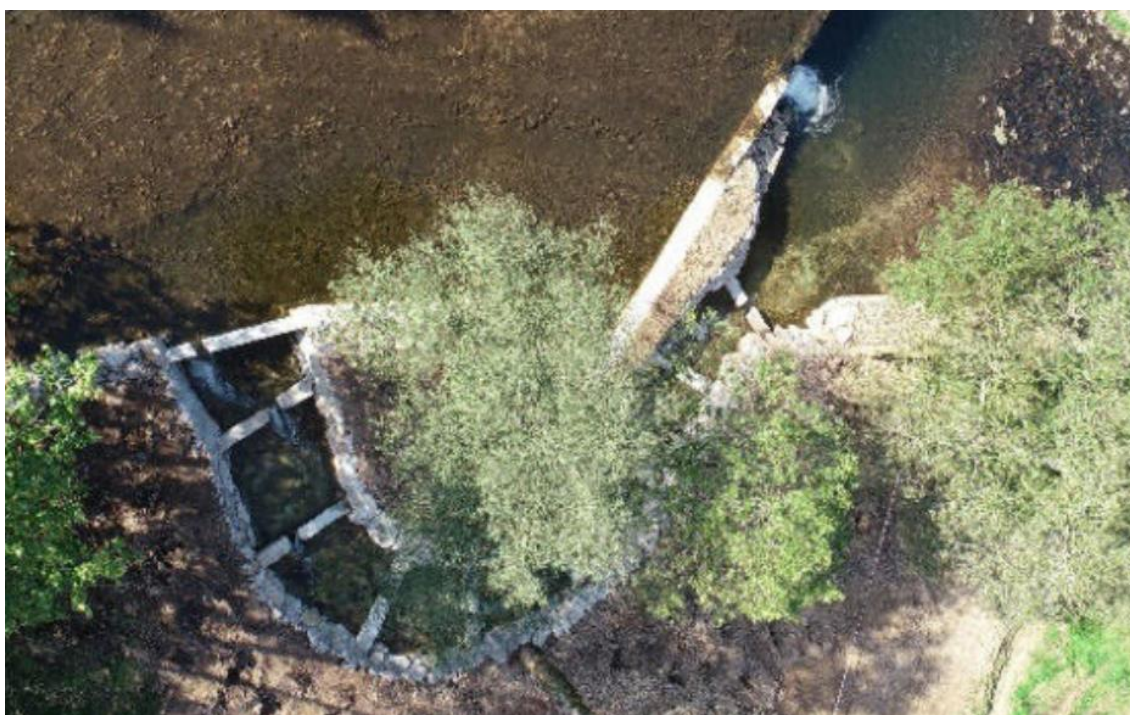
Permeabilización del azud de Villafufre. Río Pisueña (Cantabria)
