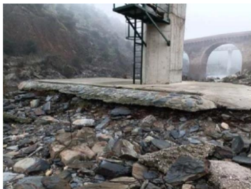
Figura 4 Desperfectos en estaciones de aforo del SAIH en el evento de diciembre de 2022
