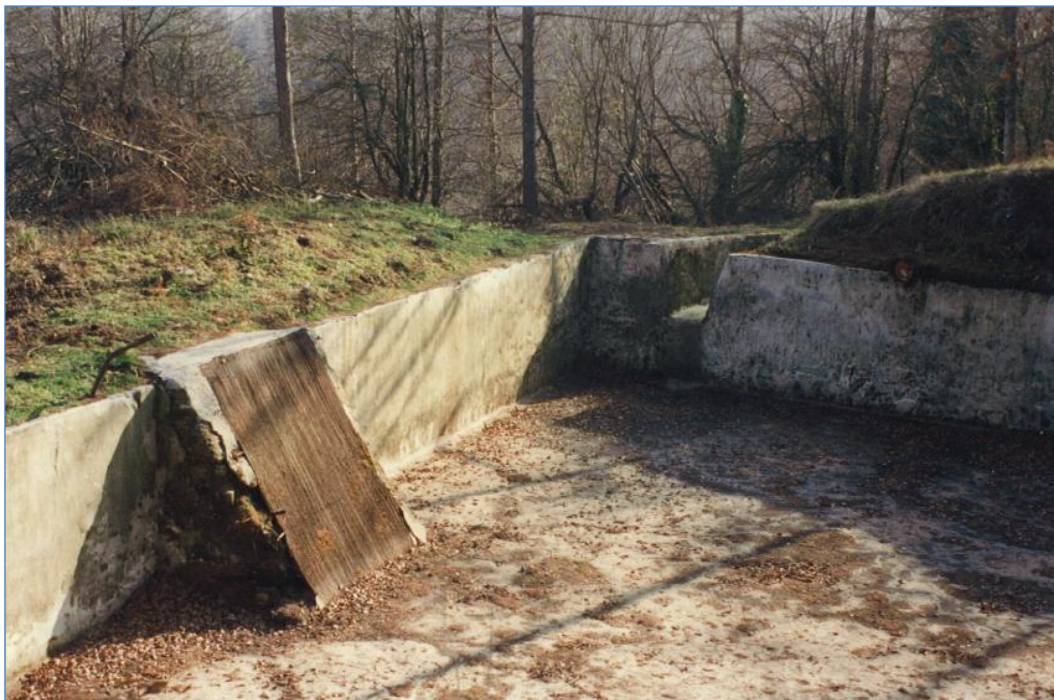
Figura 128. Antigua cámara de carga de la central hidroeléctrica de Aldaola. Foto: M. Omedas, CH del Ebro, 1989.
