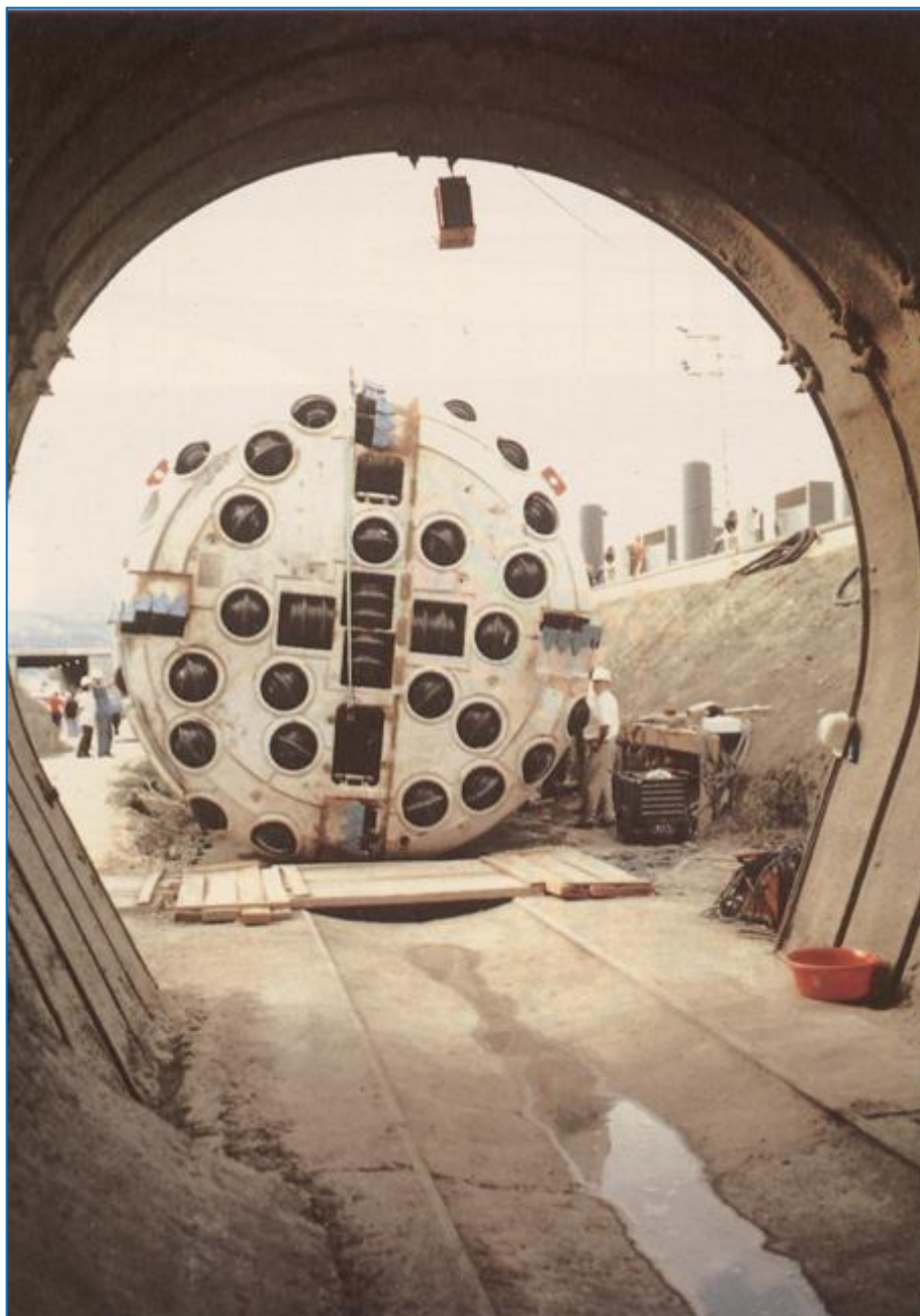
Figura 53. Imagen del frente de la tuneladora en las obras de perforación del túnel de Buitreras. Foto: Archivo de la I Bienal de Arquitectura, 1998.
