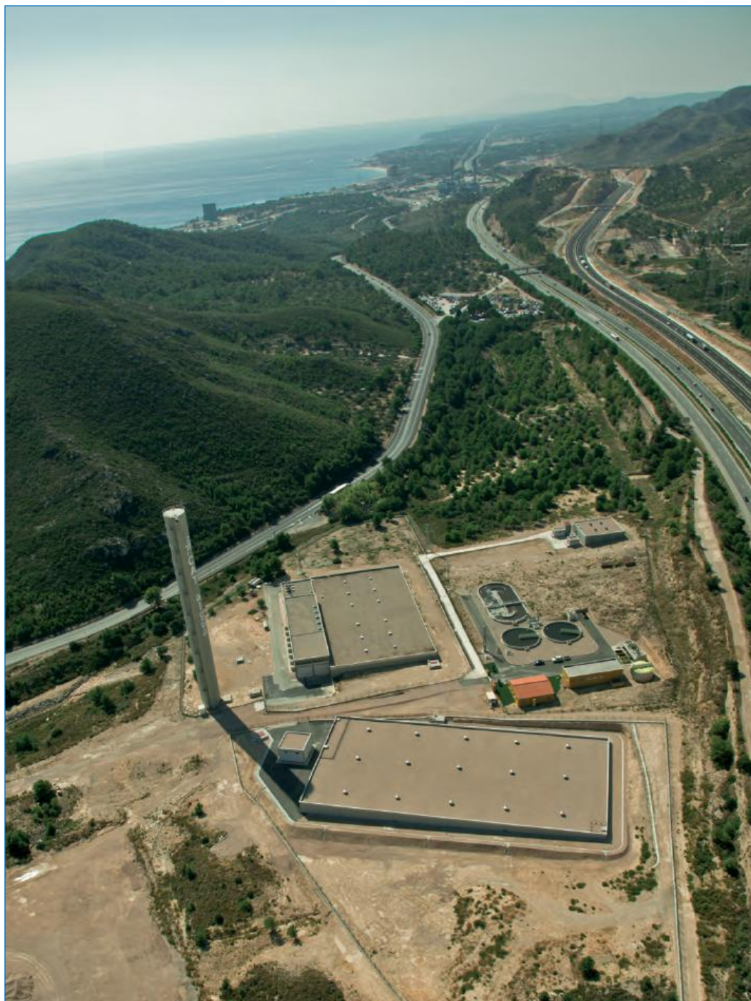
Figura 40. Chimenea de equilibrio, depósitos y bombeo del Coll de Balaguer. Foto: Consorcio de Aguas de Tarragona, T. Carot Giner (2014).
