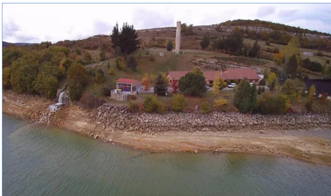
Figura 91. Trasvase Ebro-Besaya: captación en el embalse del Ebro, estación de bombeo, chimenea de rotura de carga y edificios de control. Foto: CH del Cantábrico.
