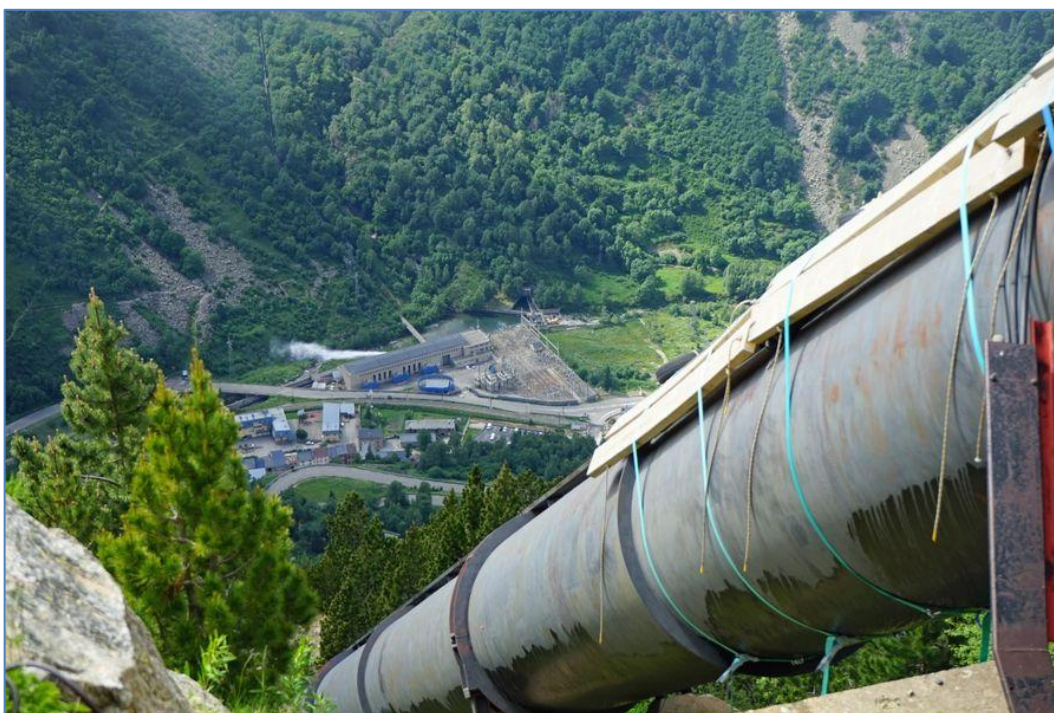
Figura 157. Conducción desde la cuenca del Carol a la central de L'Hospitalet, en el río Ariège, en el centro de la imagen. Foto: www.usinenouvelle.com
