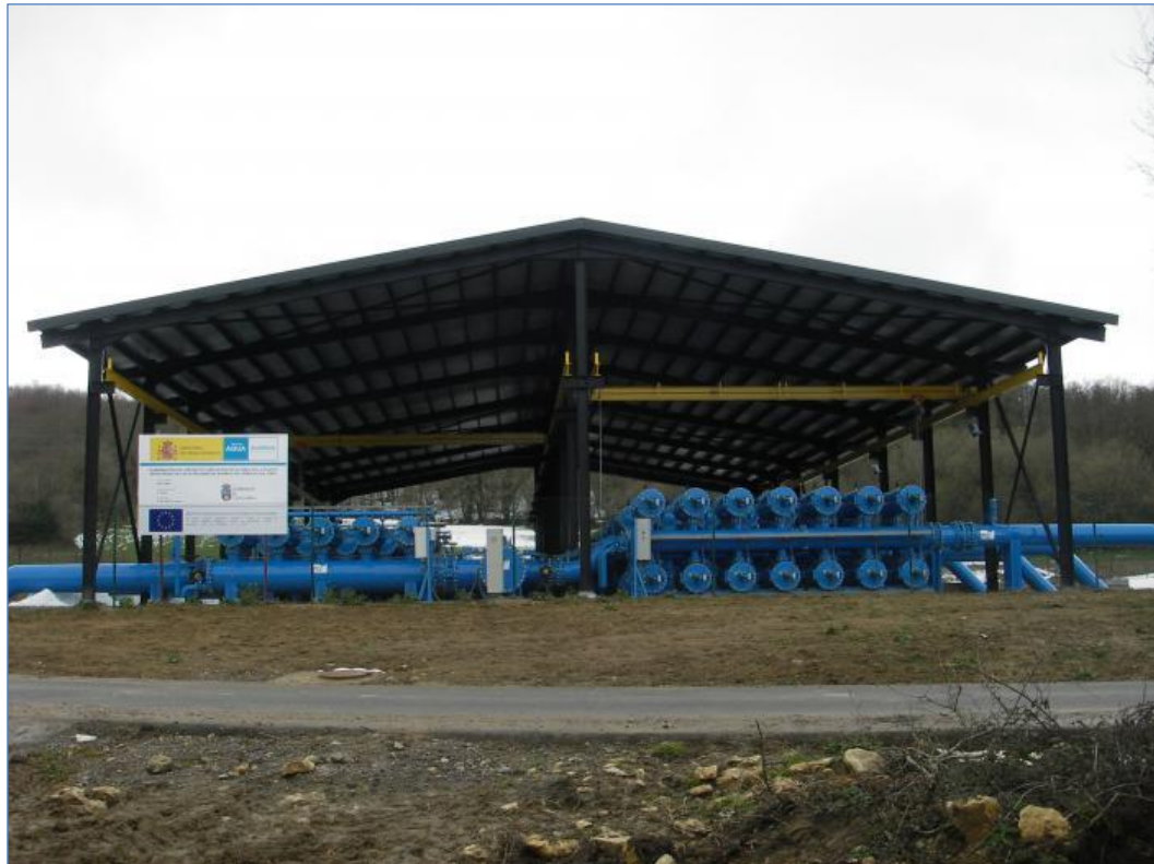
Figura 93. Imagen de la estación de filtrado construida en la nueva toma del embalse del Ebro para evitar la propagación del mejillón cebra. Foto: ACUAES.
