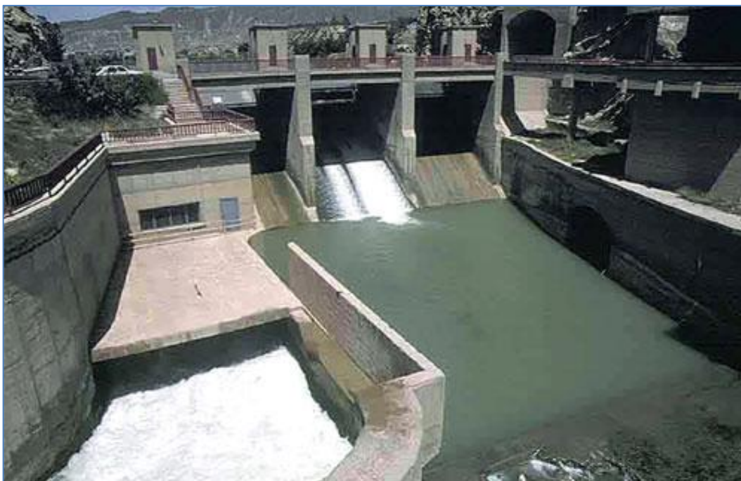
Figura 7. Azud de Ojós, sobre el cauce del río Segura en Blanca (Murcia), con el arranque del canal principal de la margen derecha. Foto: CH del Segura.
