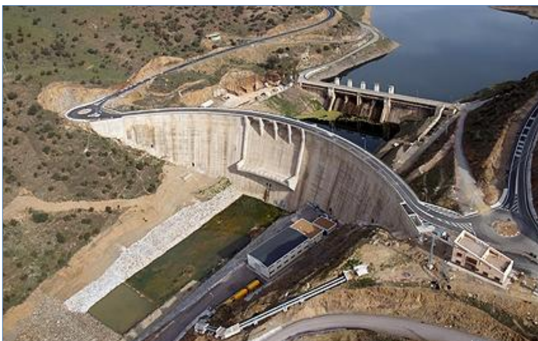
Figura 131. Embalse de Montoro. Obra de recrecimiento. Fotografía tomada de www.construccionesalpi.es
