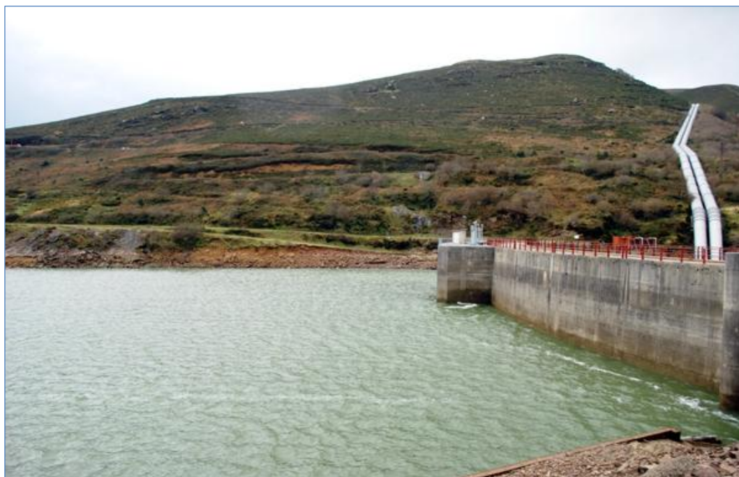
Figura 96. Presa de Alsá (río Torina, cuenca cantábrica del Besaya) y conducciones al embalse de Mediajo. Foto: Blog de viajes de Alsá.
