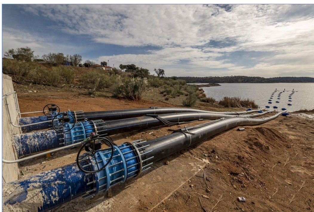
Figura 116. Captación en el embalse de La Colada (Guadiana) para conducir las aguas hasta Sierra Boyera (Guadalquivir). Fotografía Europa Press.
