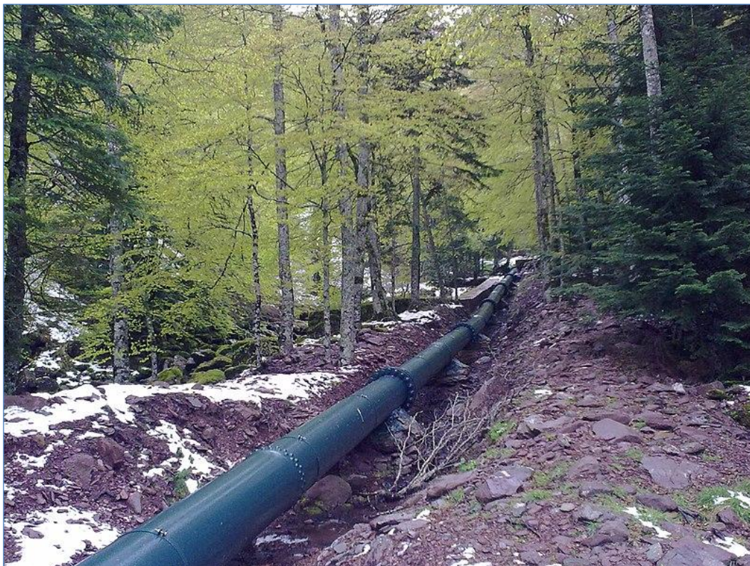
Figura 162. Aspecto de la conducción forzada desde el ibón de Estanés a la central eléctrica de Espelunguère. Foto del 21 de mayo de 2010, tomada de: https://fr.wikipedia.org/
