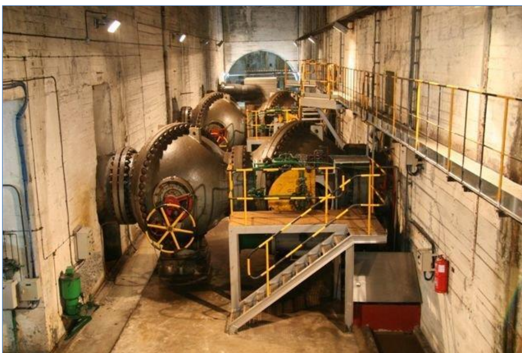
Figura 22. Válvulas esféricas en el tramo final de la conducción a los dos grupos generadores de la central de Barazar. Foto: Iberdrola.
