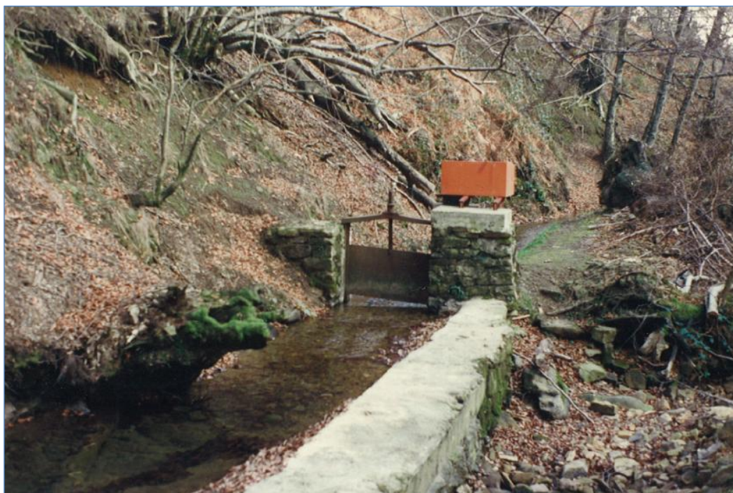
Figura 127. Azud e inicio del canal de trasvase equipado con limnógrafo, en el arroyo Ubiergo, cabecera del Alzania. Foto: M. Omedas, CH del Ebro, 1989.
