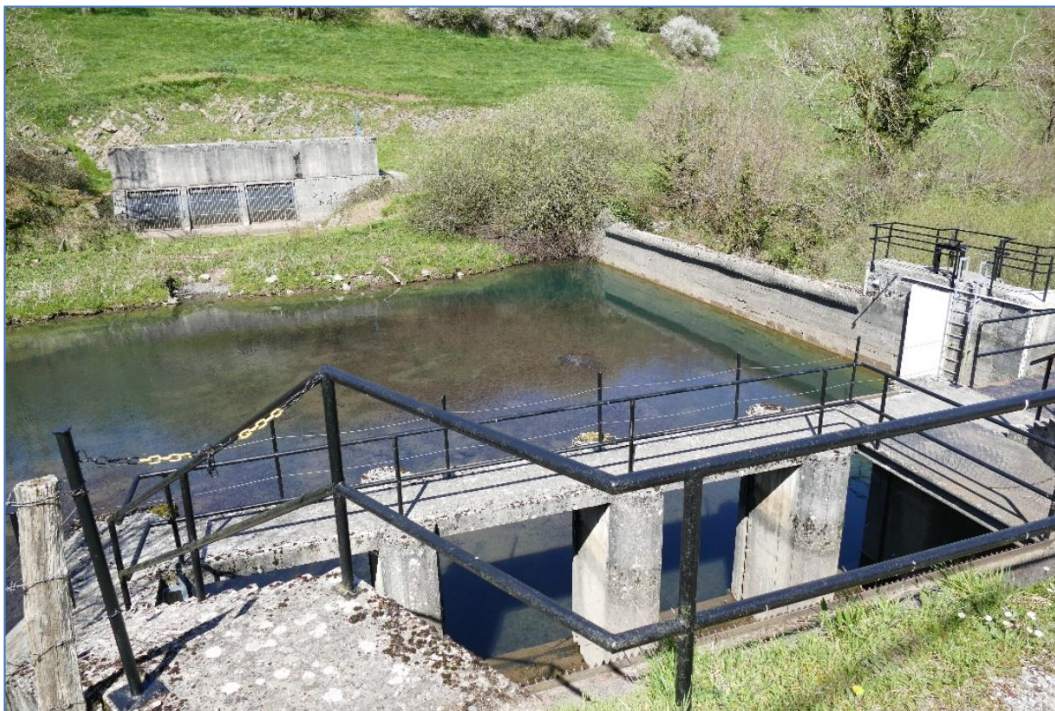
Figura 89. Azud de Aguayo. En primer término, compuertas de acceso al túnel que facilita el paso de las aguas hacia la cuenca del Ebro.
