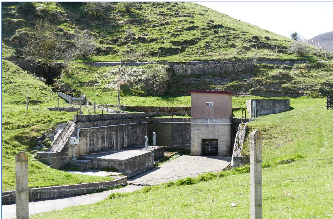
Figura 95. Boca norte del túnel de la Virgen de las Nieves (cuenca cantábrica) y arquetas de captación de las aguas procedentes del embalse del Ebro.
