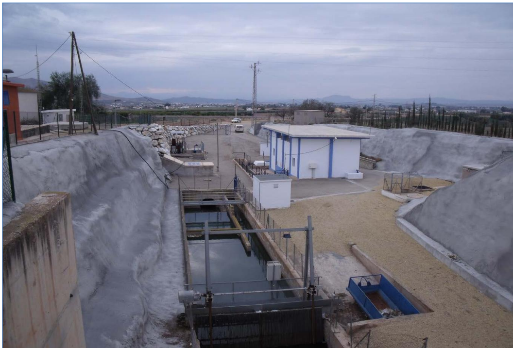
Figura 46. El Saltador (Huércal-Overa, Almería), donde se reúnen las aguas del canal de la margen derecha del postrasvase (ATS) con las de la conexión Negratín-Almanzora, y desde donde parte la conducción al embalse de Cuevas de Almanzora. Foto: Gil Meseguer y Gómez Espín, 2015.
