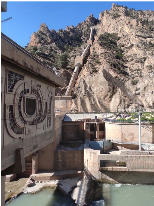
Impulsión desde el Azud de Ojós
