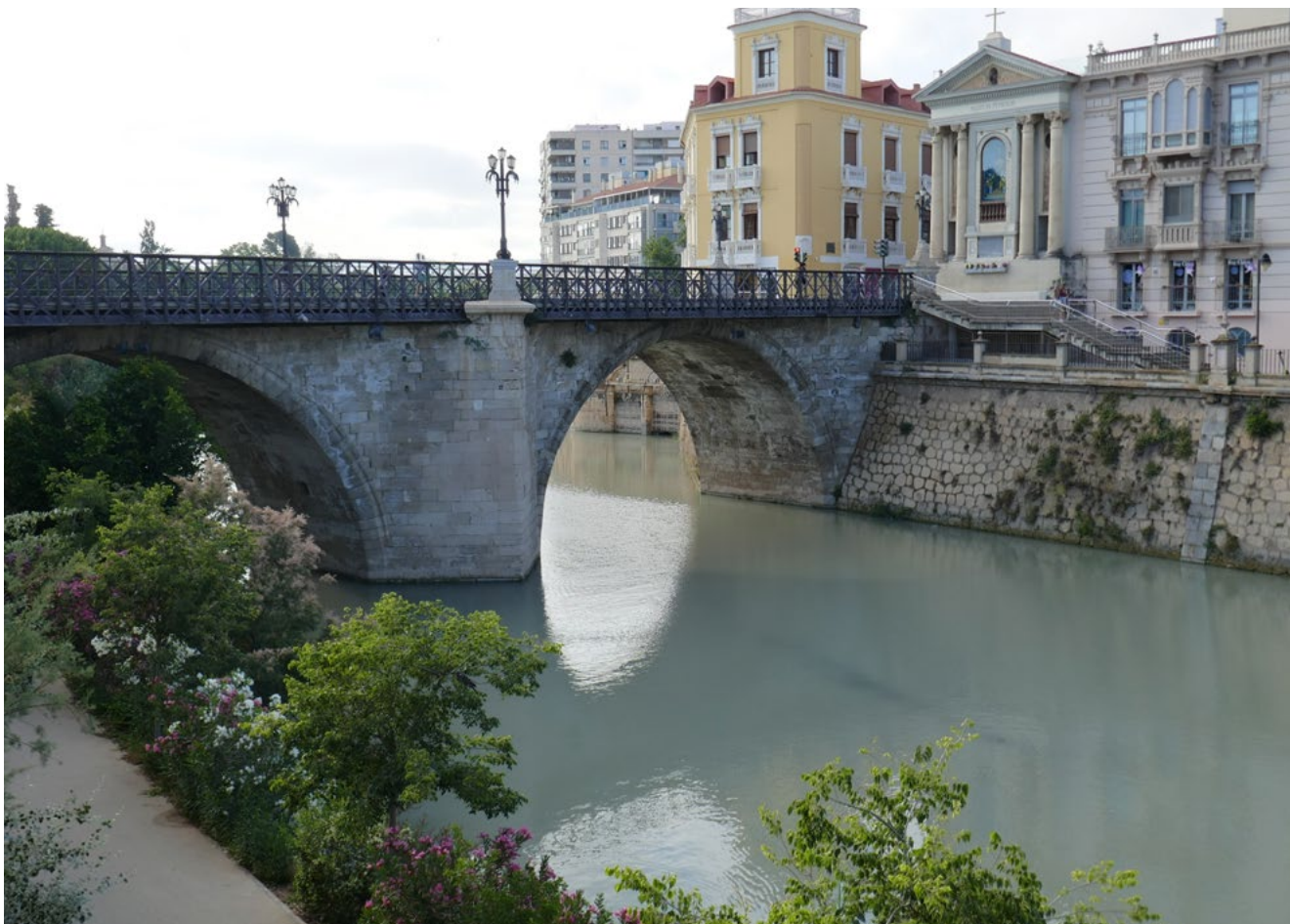
Senda peatonal en la orilla del río Segura
