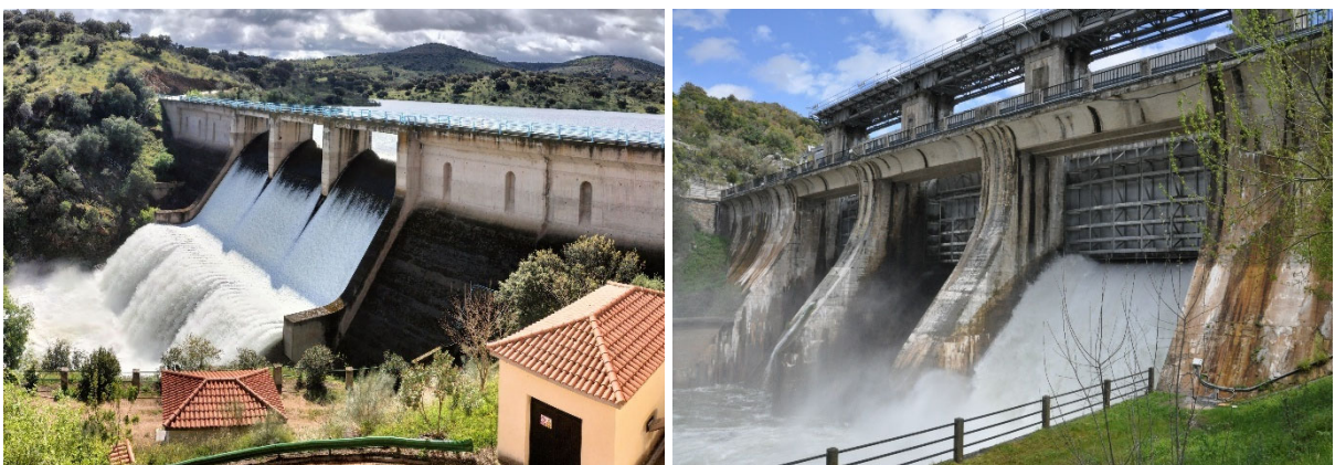
Figura 7. Evacuación de avenida en presa con aliviadero de labio fijo (presa del Gévalo, izquierda) y en presa con aliviadero regulado con compuertas (presa de Rosarito, derecha)
