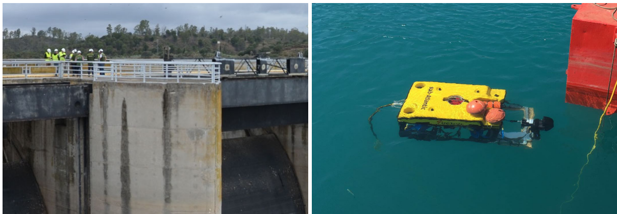
Figura 4. Inspección visual (izquierda) y de reconocimiento subacuático con ROV (derecha)
