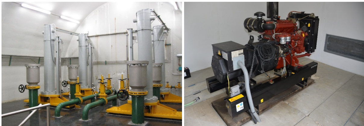
Figura 6. Equipos en desagües de fondo (izquierda) y grupo electrógeno (derecha)
