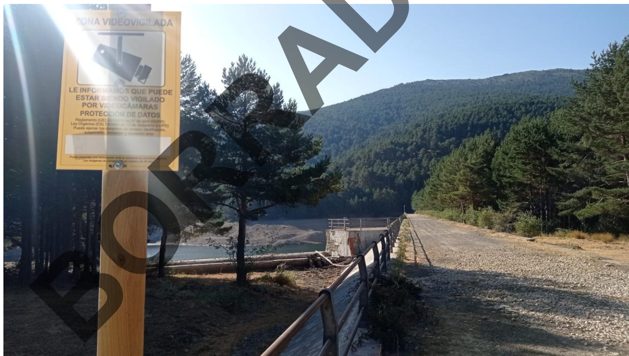
Imagen 63. Cartel de aviso de advertencia de videovigilancia a la entrada de la coronación de una presa
