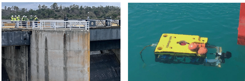
Figura 4. Inspección visual (izquierda) y de reconocimiento subacuático con ROV (derecha)
