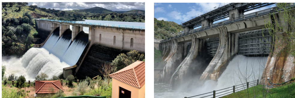
Figura 7. Evacuación de avenida en presa con aliviadero de labio fijo (presa del Gévalo, izquierda) y en presa con aliviadero regulado con compuertas (presa de Rosarito, derecha)
