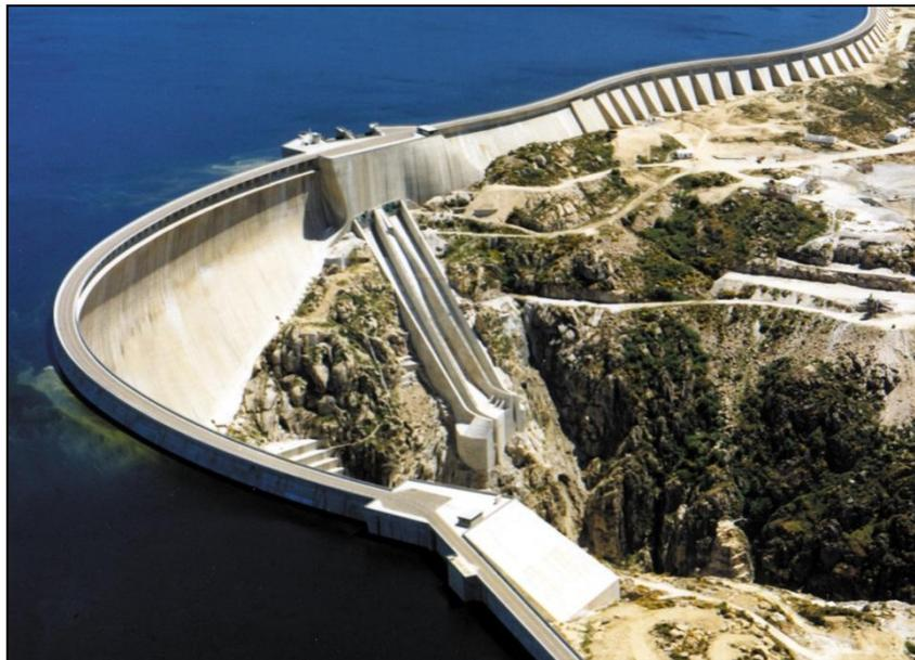
**Ilustración 6:** Presa tipo bóveda de La Almedra en el río Tormes (Salamanca y Zamora), la de mayor altura construida en España (202 m).
