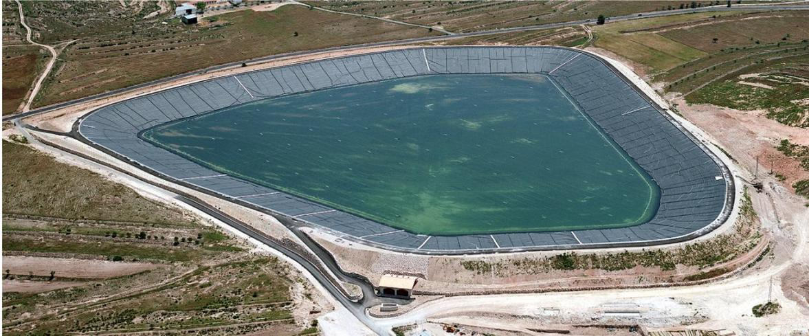
**Ilustración 8: En España existen balsas de gran tamaño impermeabilizadas con geomembranas para regulación de grandes zonas regables.**
