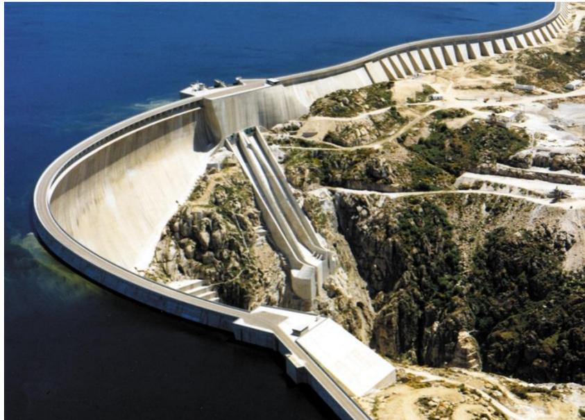
**Ilustración 2: Presa tipo bóveda de La Almedra en el río Tormes (Salamanca y Zamora), la de mayor altura construida en España (202 m).**
