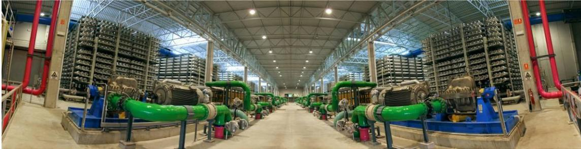
**Ilustración 20: Edificio de ósmosis de la planta desaladora de Torre Vieja (España).**
