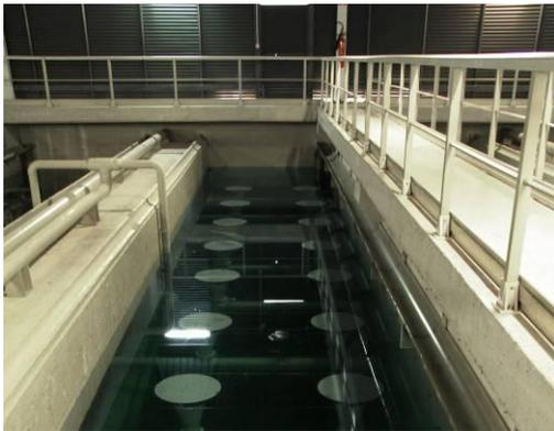
**Ilustración 11: Módulo de filtro abierto.**
