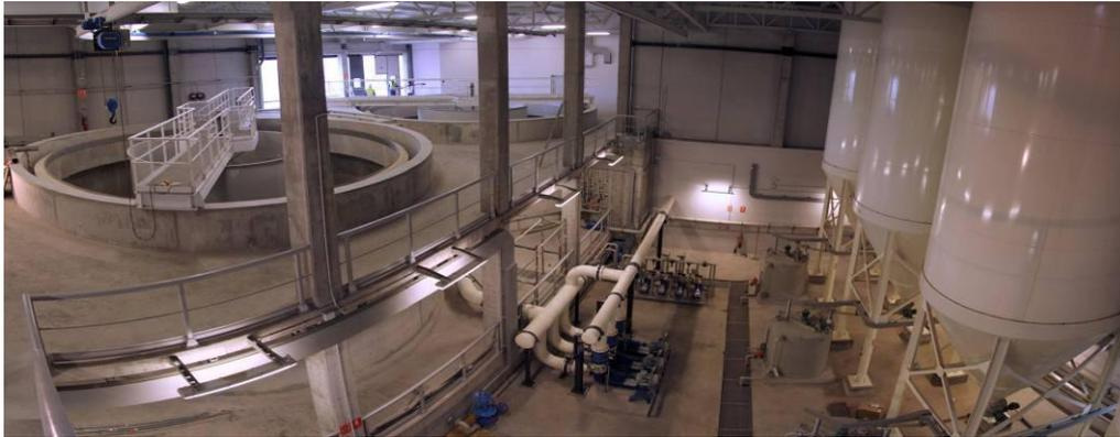
**Ilustración 16: Remineralización. Silos de cal y saturadores de mezcla.**
