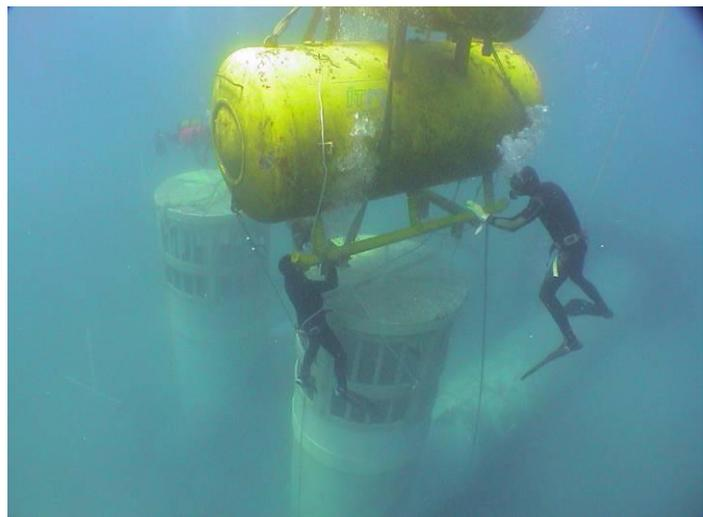
**Ilustración 25: Colocación de la obra de toma de la desaladora de Carboneras (España).**
