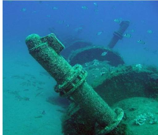
**Ilustración 18: Emisario de bocas difusoras de la desaladora del Bajo Almanzora (España).**
