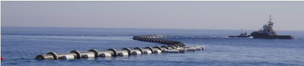
**Ilustración 24: Colocación de las conducciones en posición para fondearlas.**
