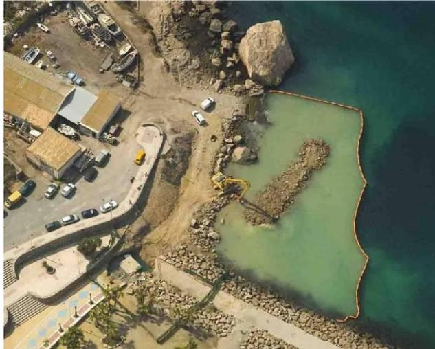
**Ilustración 30: Retención de sólidos en suspensión mediante barreras antiturbidez.**
