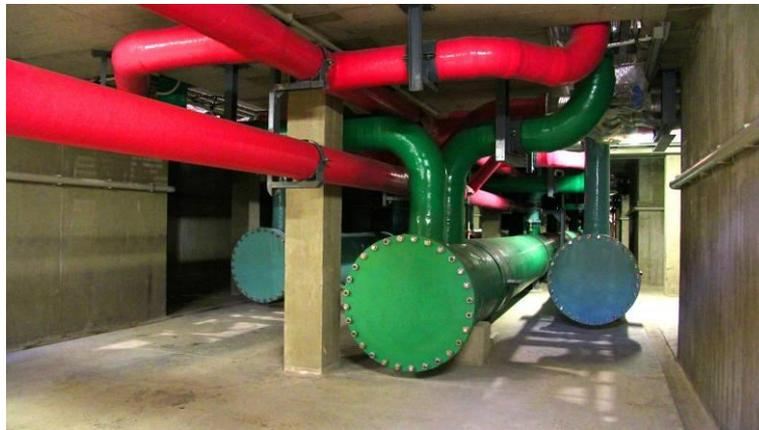
**Ilustración 21: Galería de conducciones de una planta desaladora bajo el edificio de ósmosis.**
