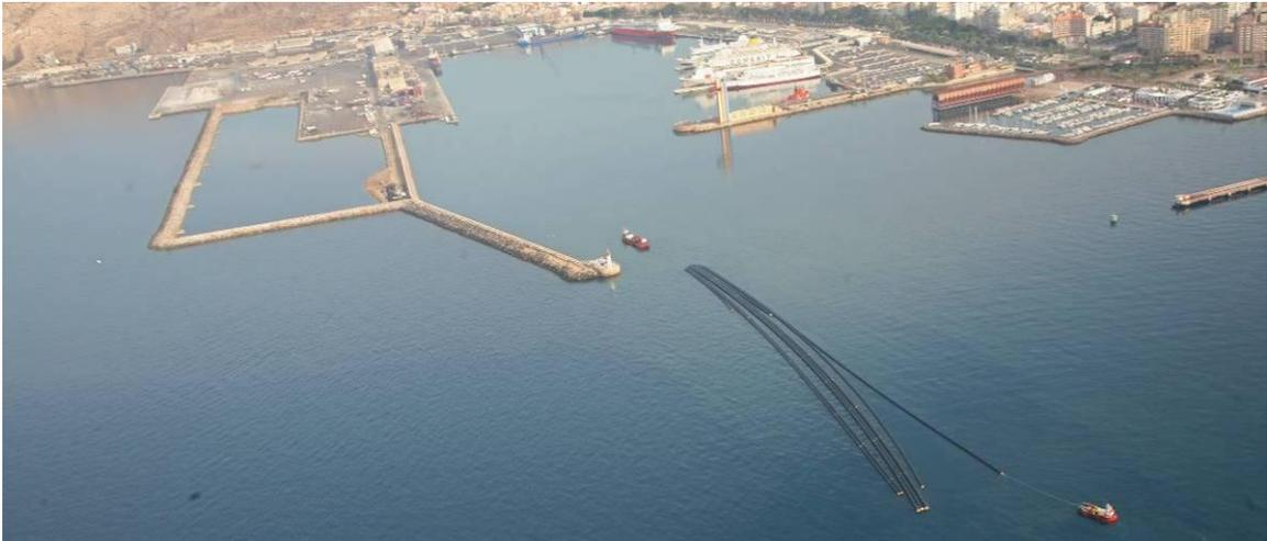
**Ilustración 23: Transporte de las conducciones de toma de la desaladora del Campo de Dalias en Puerto de Almería (España).**
