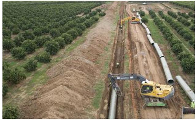
**Ilustración 13: Construcción de una conducción de agua para riego.**
