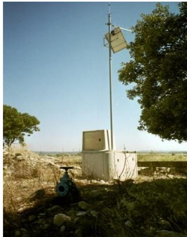
**Ilustración 4: Telecontrol de hidrante.**
