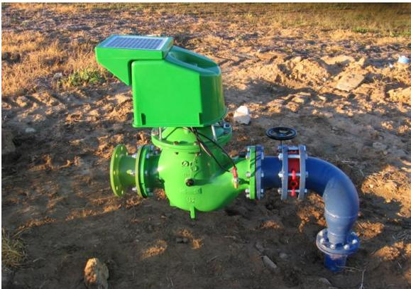
**Ilustración 10: Foco hidrante con placa solar.**
