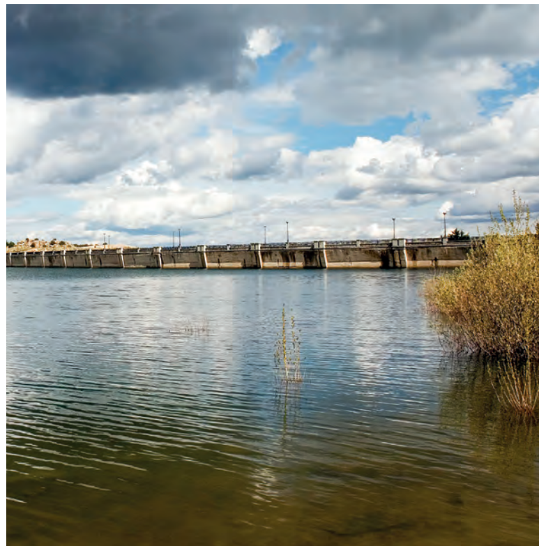
Presa de Navacerrada, cuenca del Tajo (Madrid)
