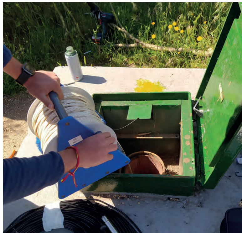
Medición manual del nivel piezométrico
