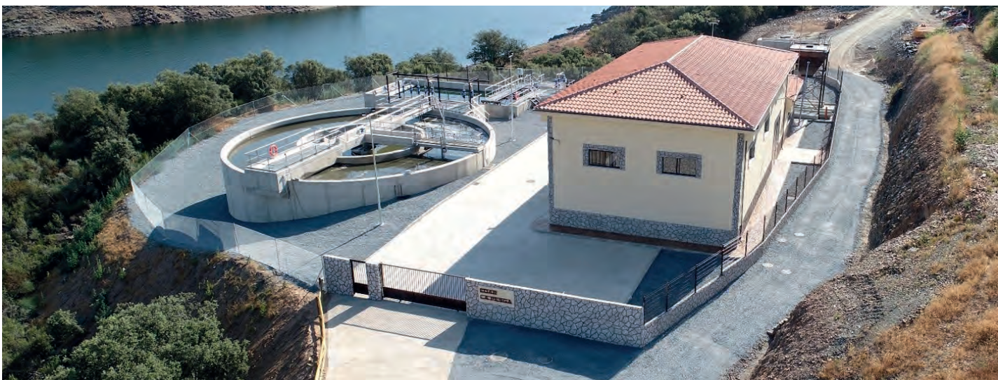
EDAR La Pesga, cuenca del Tajo (Cáceres, Extremadura)
