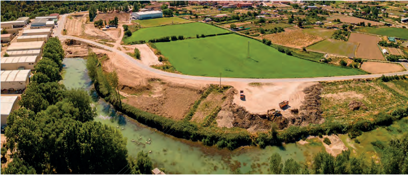
Restauración fluvial del río Arga en Funes, cuenca del Ebro (Navarra). Conexión de meandro abandonado del río Arga
