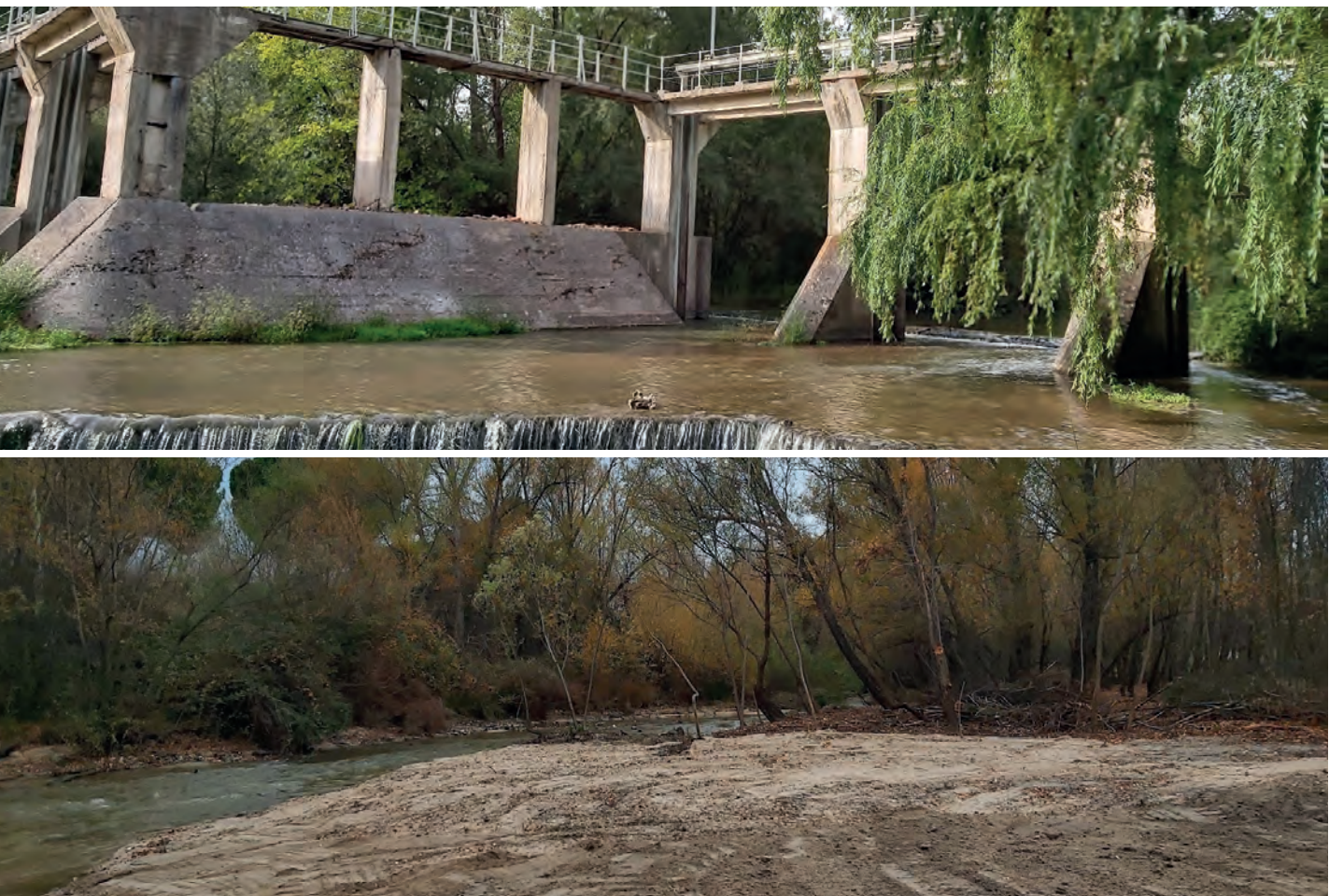
En la primera imagen azud obsoleto en el río Manzanares, cuenca del Tajo, en El Pardo (Madrid). En la segunda imagen, azud ya demolido
