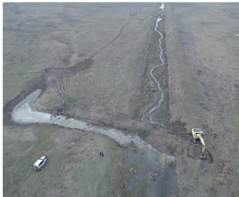
Restauración fluvial del río Zapardiel en la cuenca del Duero
