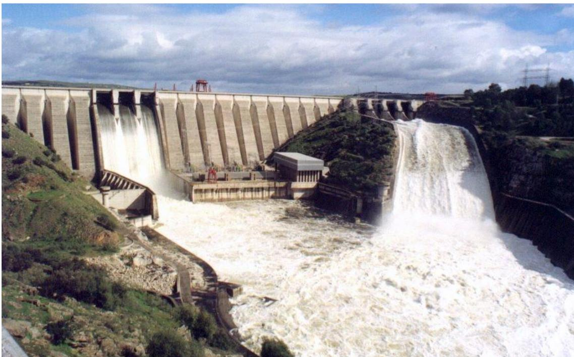
**Ilustración 1: Desagüe de la presa de Alcántara (Iberdrola) en la cuenca hidrográfica del Tajo. Los embalses son elementos claves en la gestión de las avenidas y, a su vez, su rotura o mal funcionamiento puede causar efectos catastróficos.**
