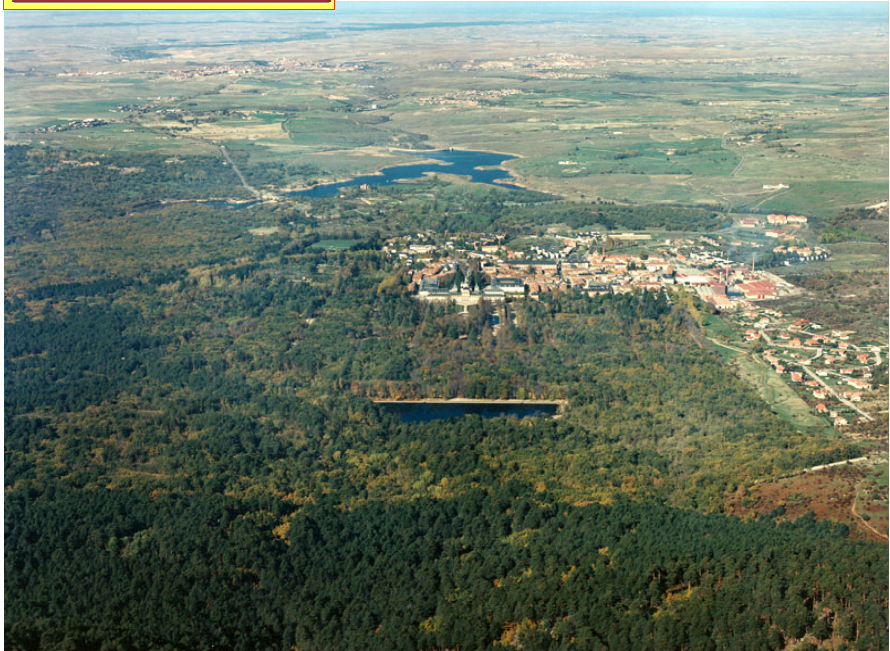
Vista aérea del conjunto desde el mar
