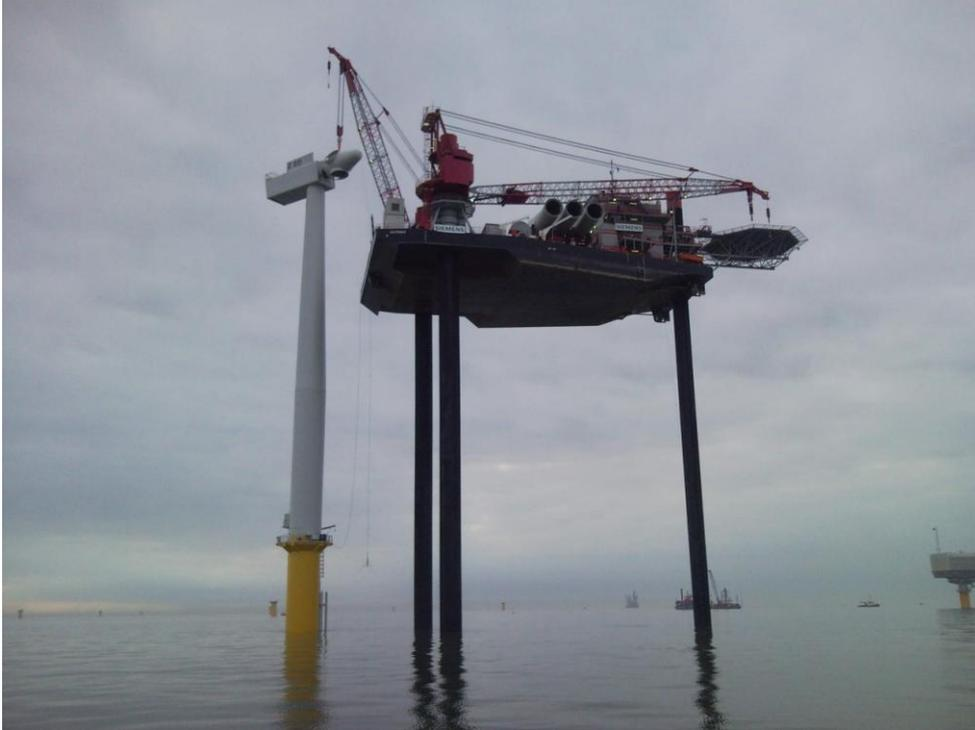
Figura 3.8 Operación de montaje de un campo eólico ©Off shore Wind Power Marine Services
