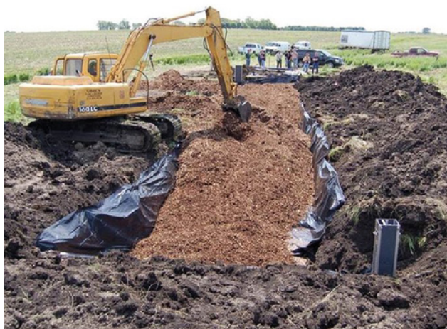
Figura 2. a) Construcción de biorreactores rellenos de astillas de madera en EE.UU. https://acsess.onlinelibrary.wiley.com/doi/full/10.1002/agg2.20149 ; b) Relleno de un biorreactor con virutas de madera para tratar efluentes de acuicultura en EE.UU (fotografía de L. Christianson/Iowa Soybean Association Environmental Programs and Services; https://www.globealseafood.org/advocate/woodchip-bioreactors-effectively-treat-aquaculture-effluent/ ).
