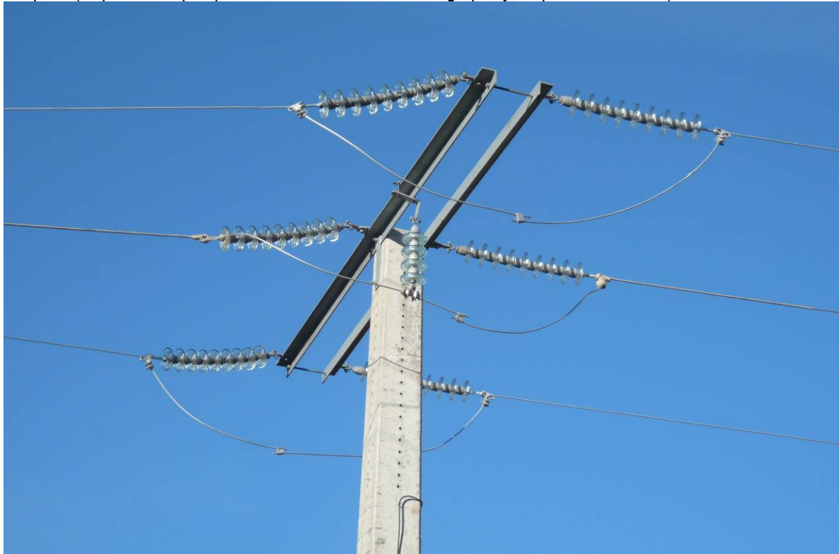
Después (es preferible que quede como el anterior, con las grapas y los puentes forrados)
