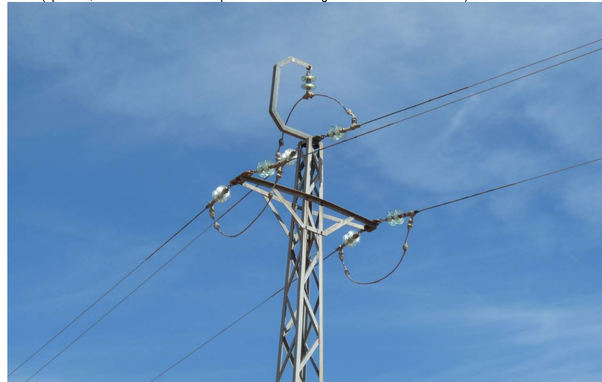
Antes (opción 2, con aislador central suspendido mediante "gitanilla" o "cuello de cisne")
