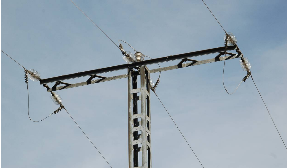
Después (es preferible que quede como el anterior, con las grapas y los puentes forrados)
