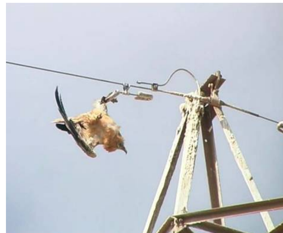
Figura 1.1: Guirre enganchado en estabilizador de tendido eléctrico. Tomada del blog de Cesar Javier Palacios http://blogs.20minutos.es/cronicaverde
