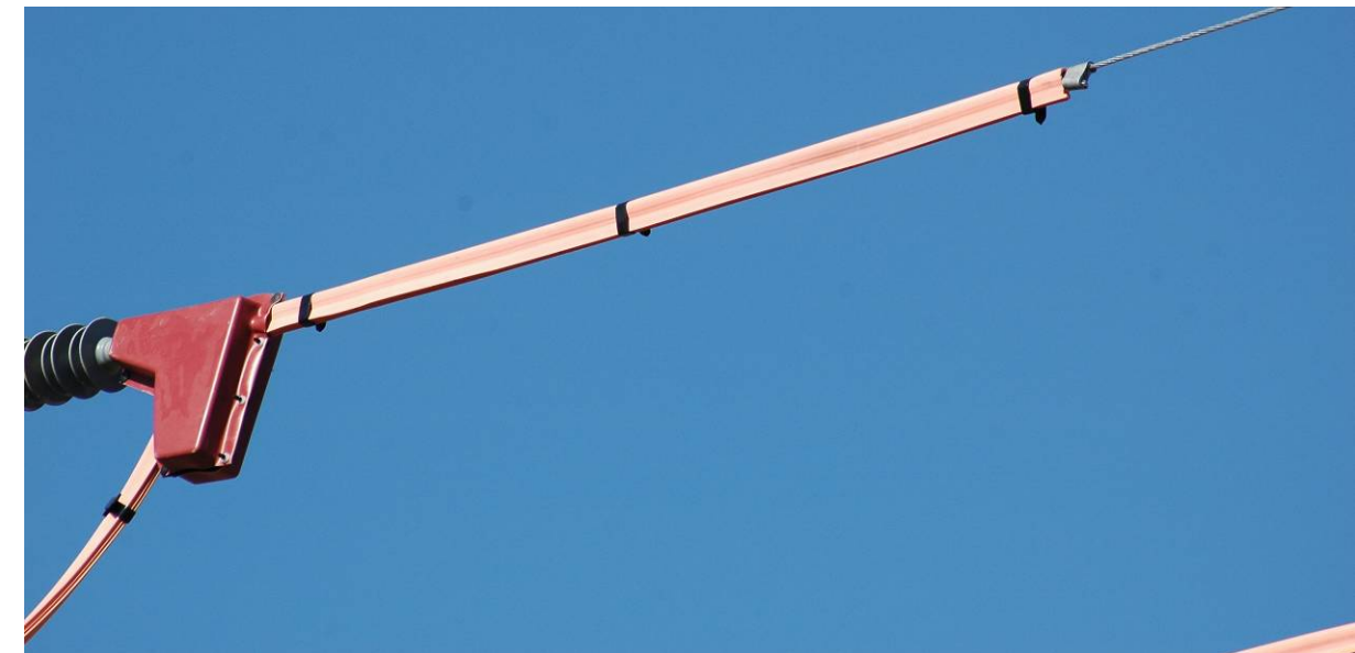
Figura A6.6: kit de aislamiento propuesto en grapas de amarre
