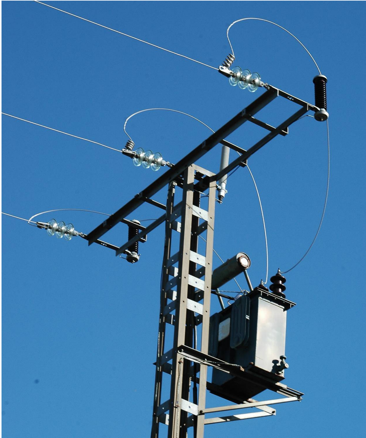
Después (a falta de aislar todas desde la grapa en adelante)
