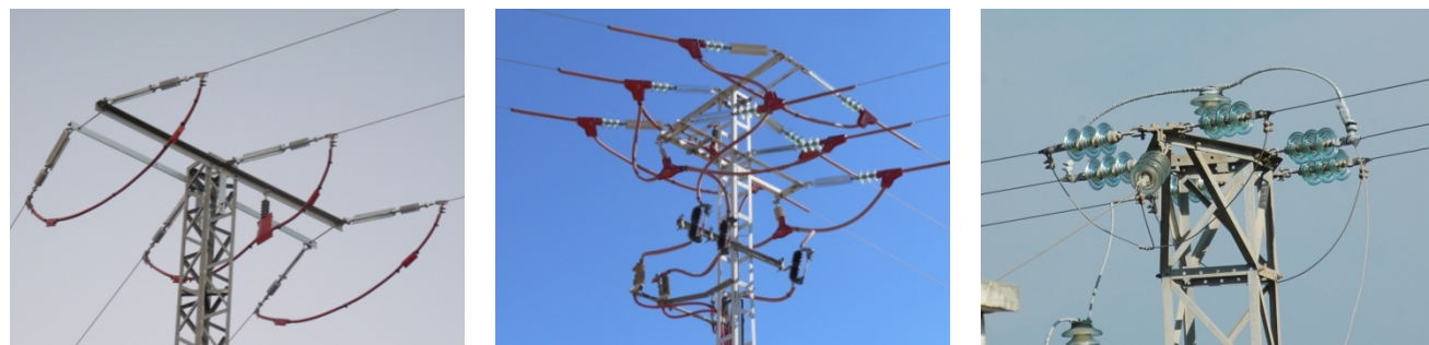
Figuras 4.5. a 4.7: Corrección de tendidos tipo LIFE, tipo FEDER y tipo aislamiento
