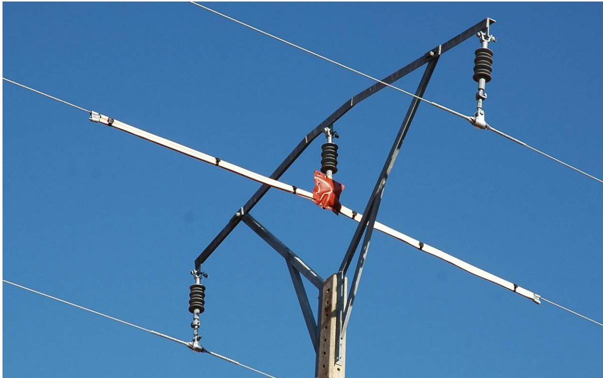
Después, opción 3: con alargamiento de las fases laterales y aislamiento de todas las fases
