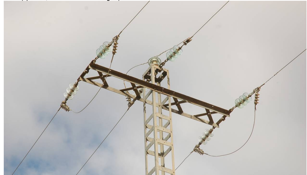
Antes (opción 2, con aislador central suspendido mediante "gitanilla" o "cuello de cisne")
