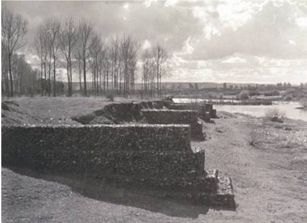
Serie de espigones de mampostería para defensa de márgenes son una solución bastante económica. (Fuente: Archivo TRAGSA)
