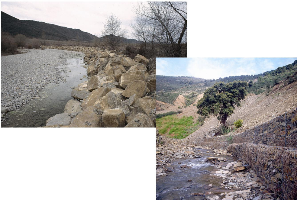
Muros longitudinales para la defensa de márgenes. (Fuente: Archivo TRAGSA)
