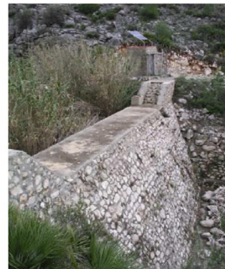
Esquema de un dispositivo de AR tipo canal de infiltración. (Fuente: Tragsatec)
