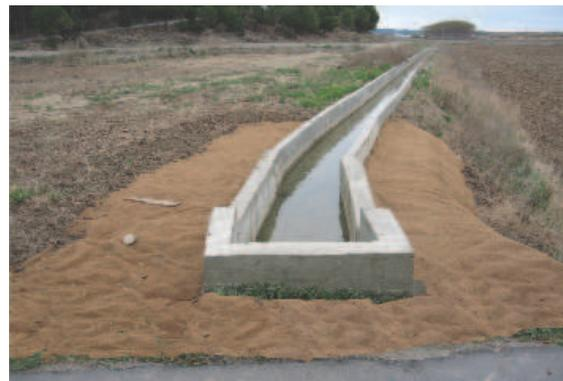
Figura 6.35. Instalación de geotextil que evita el desarrollo de la vegetación en el tramo de intersección entre la acequia y el sifón con la carretera. Foto: GAVRN, LIFE GERVE.
