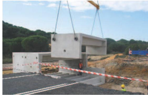
Figura 6.22. Construcción de pasos inferiores con módulos prefabricados. Foto: Junta de Andalucía
