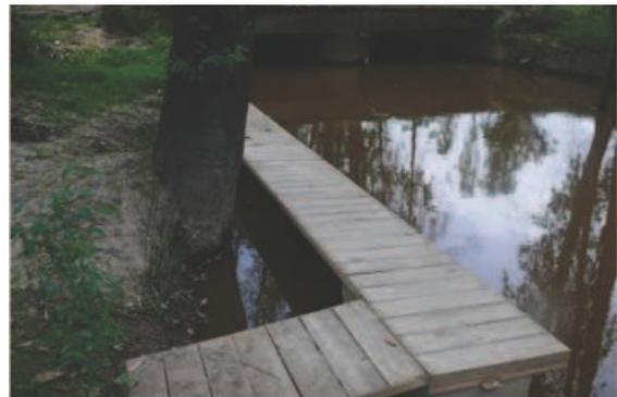
Figura 6.19. Adecuación de drenaje con banqueta lateral en Camino asfaltado. Foto: Junta de Andalucía LIFE06NAT/E/209.
