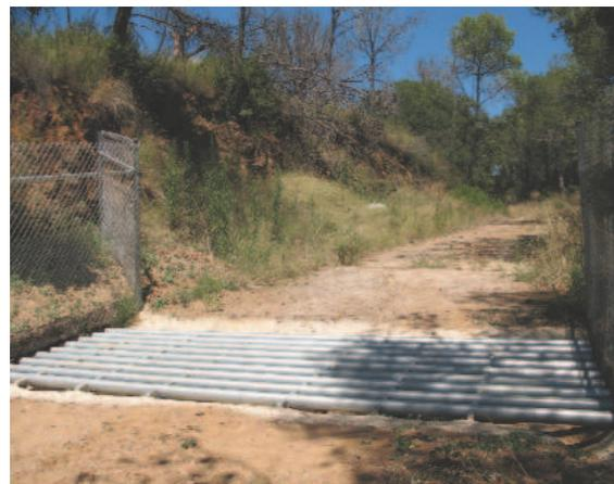
Figura 6.15. Para evitar el acceso de los ungulados a la vía, se propuso la instalación de cerramiento perimetral en todos tramos con desdoblamiento previsto y de pasos canadienses en los accesos de los caminos a la carretera. Foto: Minuartia.
