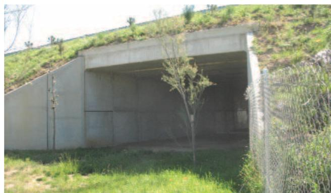
Figura 6.7. Paso de fauna y cerramiento perimetral instalados en un Tramo de Concentración de Colisiones con Ungulados de atención prioritaria. Foto: Minuartia.
