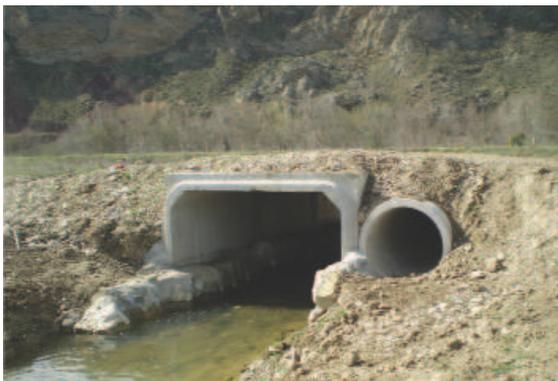
Figura 6.34. Combinación de marco prefabricado con banquetta lateral en la margen izquierda y un tubo seco en la margen derecha. Foto: GAVRN, LIFE GERVE.
