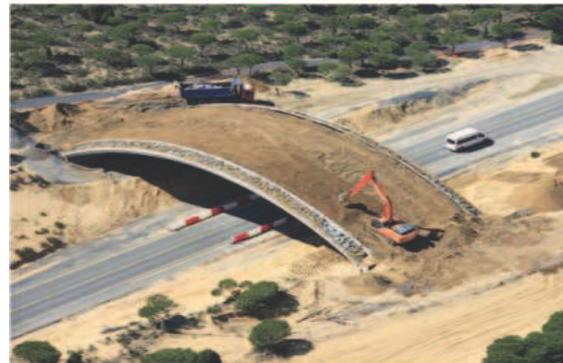
Figura 6.24. Construcción de pasos superiores. Foto: Junta de Andalucía
