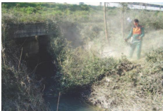
Figura 6.39. Trabajos de desbroce en los accesos a la estructura. Año 2009 Foto: GAVRN.
