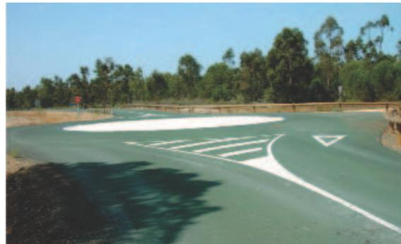
Figura 6.32. Firme coloreado y glorietas para ralentizar el tráfico. Foto: Junta de Andalucía.
