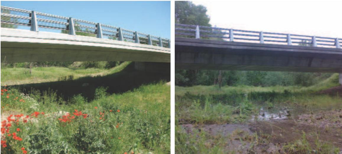
Figura 6.57. El viaducto que sustituyó a los tubos de acero corrugado aumenta de manera notable la permeabilidad de la carretera en su intersección con el corredor de la Mugueta. Fotos: Minuartia.
