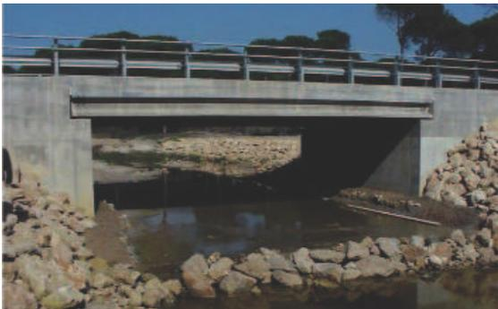
Figura 6.29. Estructura sobre un cauce con banquetas laterales y diques entre orillas. Foto: Junta de Andalucía.
