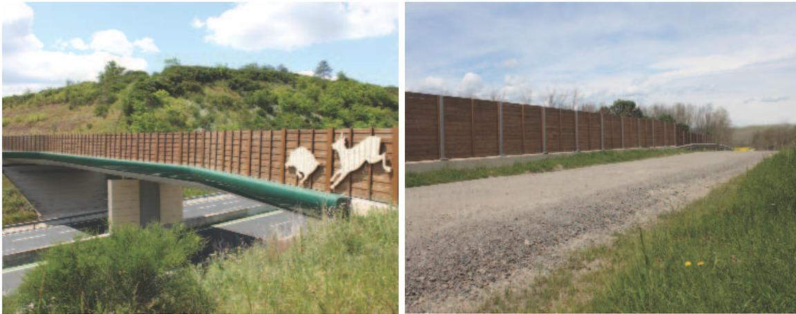
Figura 5.5. Los pasos superiores pueden acondicionarse para facilitar el paso de fauna adecuando márgenes con cobertura vegetal y con apantallamientos para evitar las perturbaciones generadas por el tráfico. Fotos: Minuartia.
