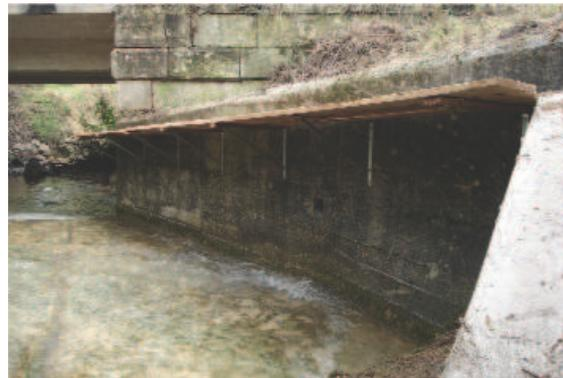
Figura 6.52. Detalle de una banqueta lateral construida en una obra de drenaje. Foto: GAVRN.
