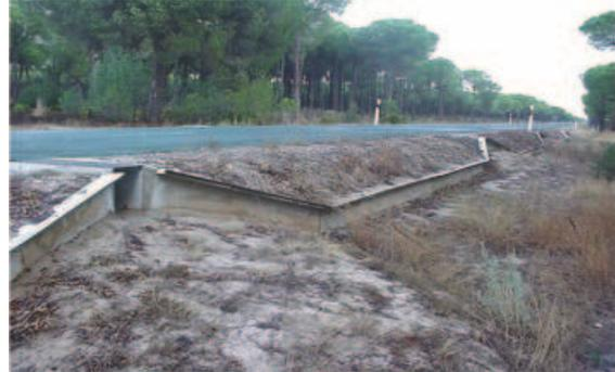
Figura 6.28. Perfiles metálicos para guiar a los anfibios hasta el paso. Foto: Junta de Andalucía.
