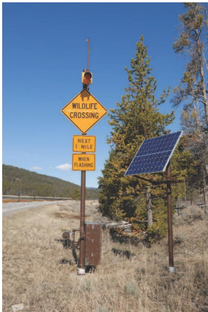
Figura 5.3. Señalización de advertencia en la que se ha instalado un sistema de sensor para la detección de fauna. Yellowstone National Park, Montana (USA). Foto: Marcel Huijser (WTI-MSU).
