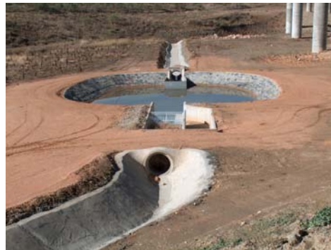
Balsa de decantación de aguas procedentes del drenaje de la plataforma en el Arroyo Salinas en la RN de El Regajal
