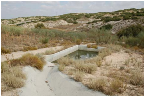
Tratamiento de agua procedente de la plataforma A-4 en la RN de El Regajal para proteger el Arroyo Cantarranas
