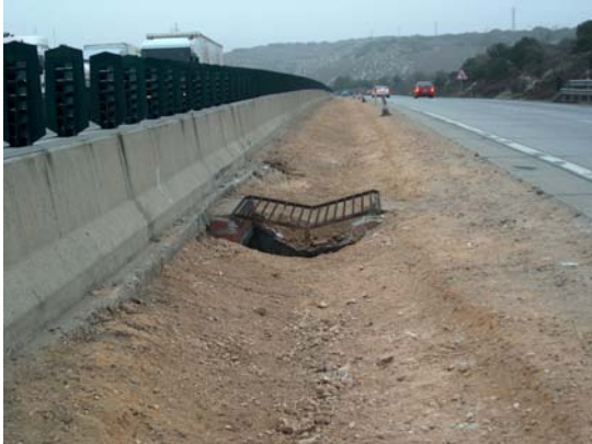
Limpieza de cunetas de la N-IV.
