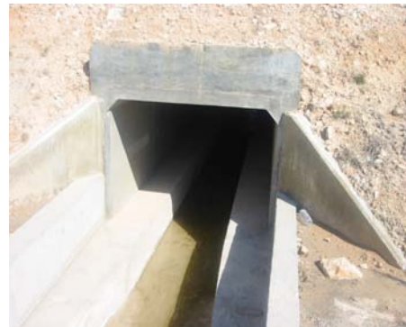
Obra de drenaje transversal adaptada como paso de fauna mediante la ejecución de bancadas secas
