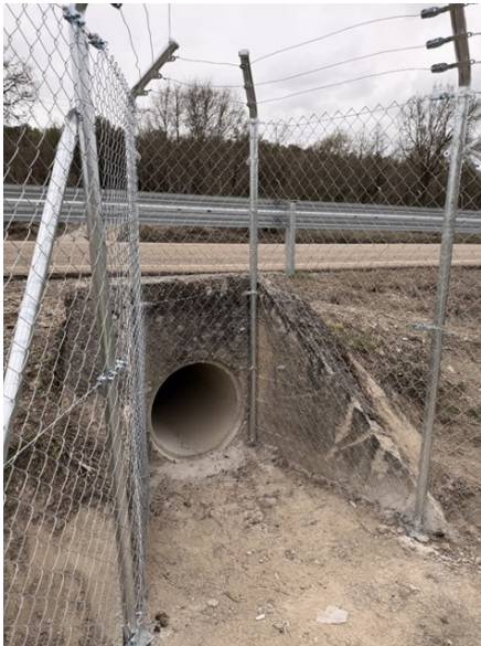
Detalle del cerramiento de la carretera P-405 en una de las embocaduras hacia un paso de fábrica.
