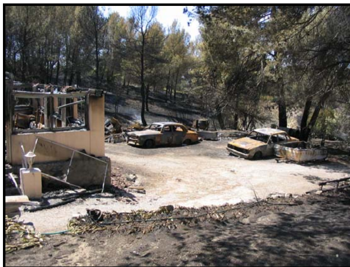
Figura 8. Los dos coches quemados a menos de 5 m. de la casa causaron una alta fuente de radiación a la estructura
