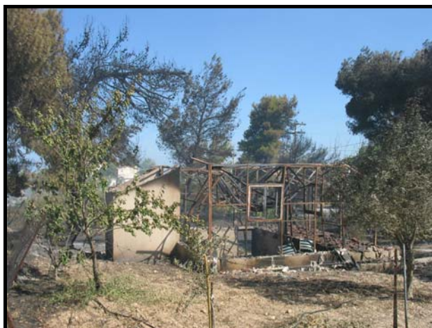
Figura 23. Vivienda de baja calidad totalmente destruida del asentamiento de Agia Triada. La presencia de vegetación verde no quemada alrededor demuestra que no fue un fuego de extremada intensidad el que acabó con esta vivienda.
