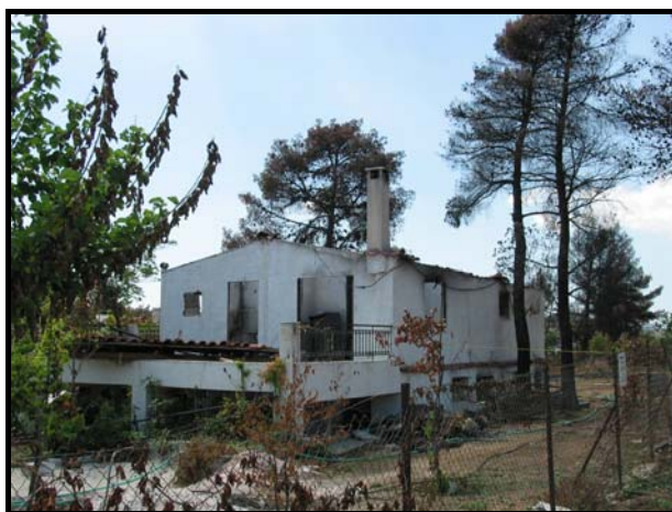
Figura 24. Otra de las viviendas quemadas en la colonia de Skoufeika. La fuente de calor provino de las copas los dos pinos quemados cerca del tejado.
