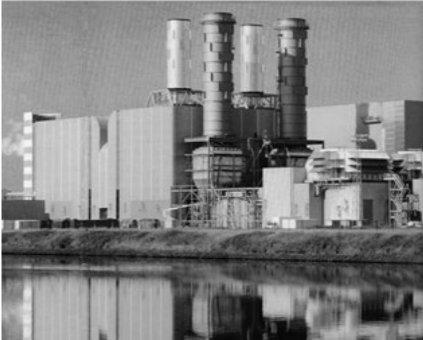
Figura 7.8: Central eléctrica de ciclo combinado con turbina de gas, de reciente construcción en Bélgica
