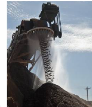
Punto de descarga con nebulización de agua
