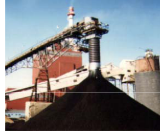
Punto de descarga con manga telescópica
