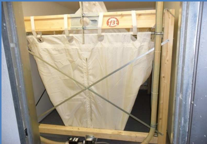
Silo textil con sistema de alimentación neumático de pellets
