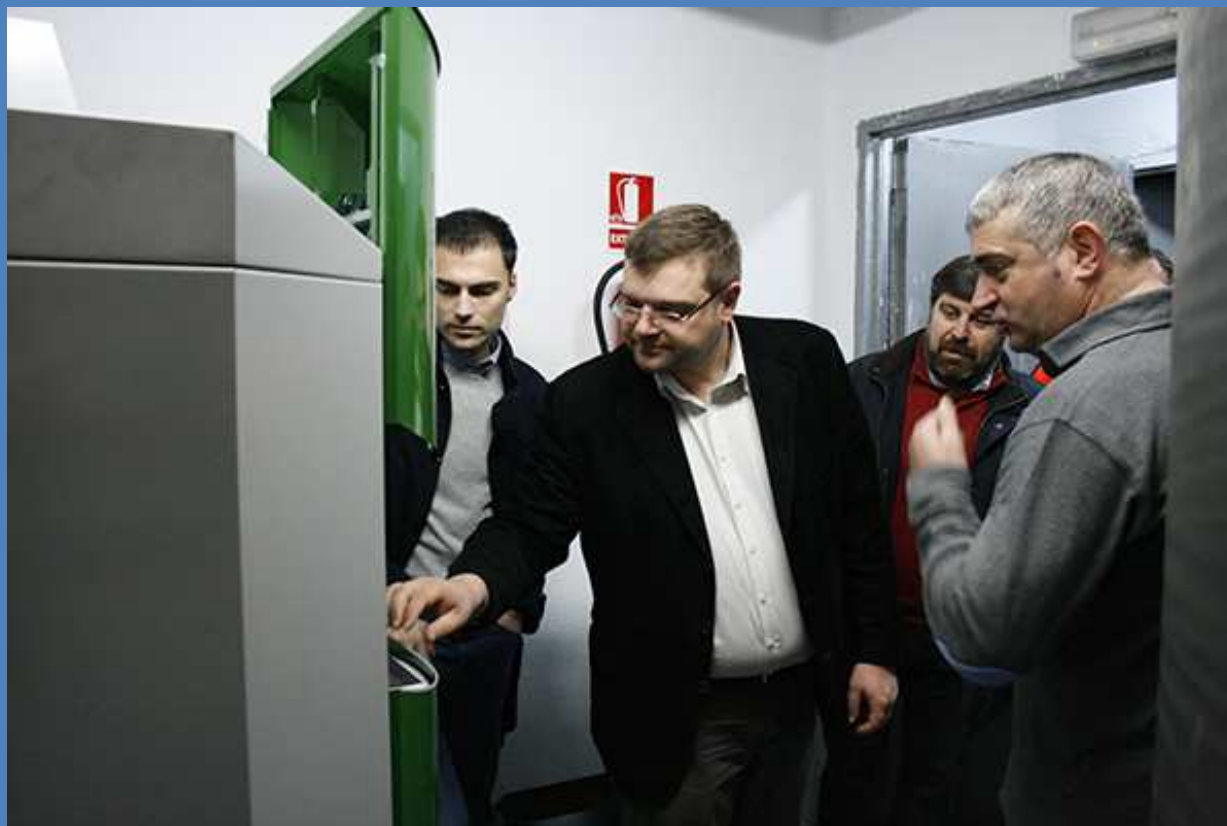
Presentación caldera biomasa en el ayuntamiento
