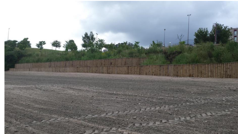
Fotografía nº7: Actuaciones de protección en la zona este de la playa do Regueiro
