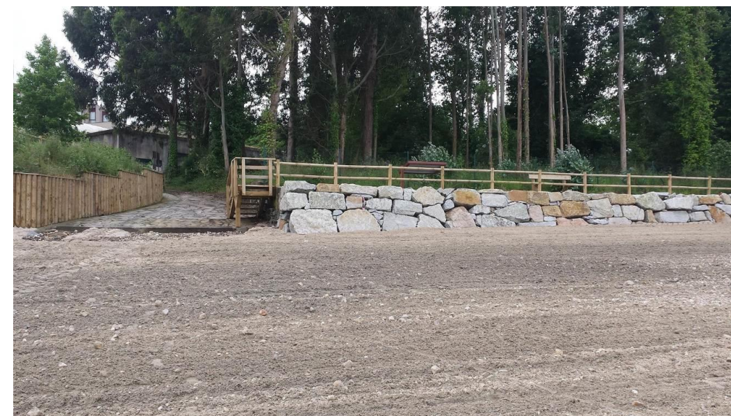
Actuaciones protección zona Este.
