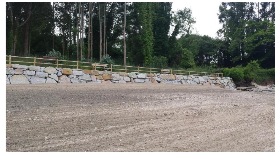
Fotografía nº12: Escollera de protección en la zona este de la playa do Regueiro
