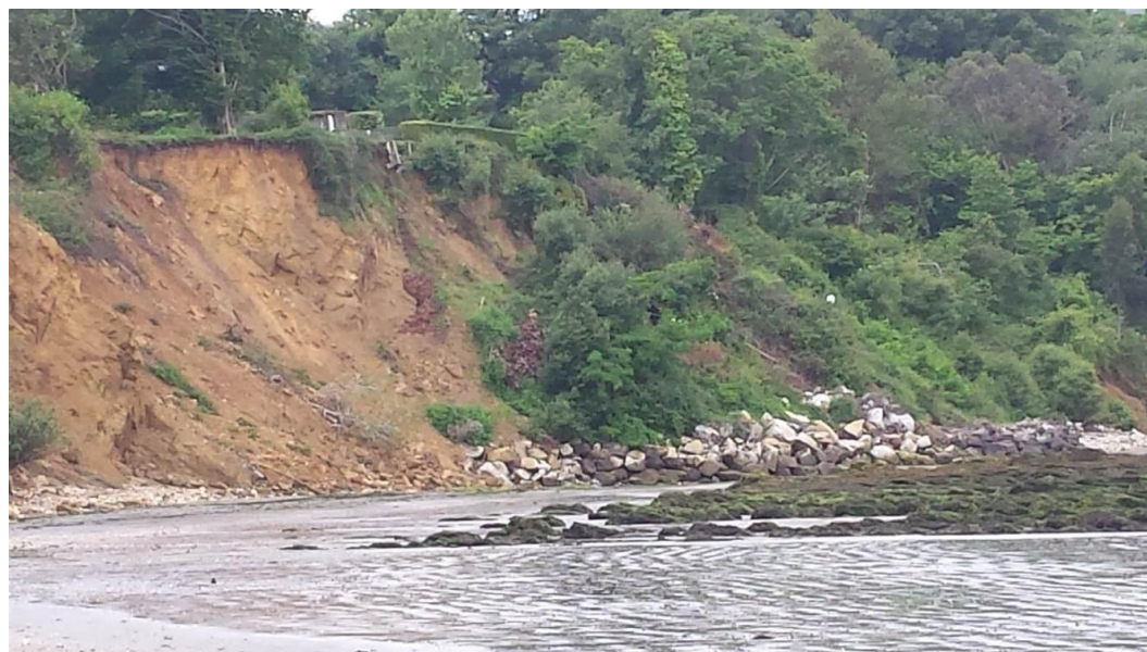
Protecciones puntuales existentes
