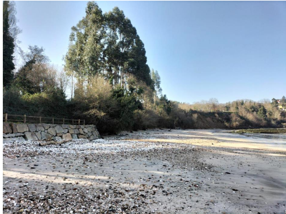
Fotografía nº13: Escollera de protección en la zona este de la playa do Regueiro
