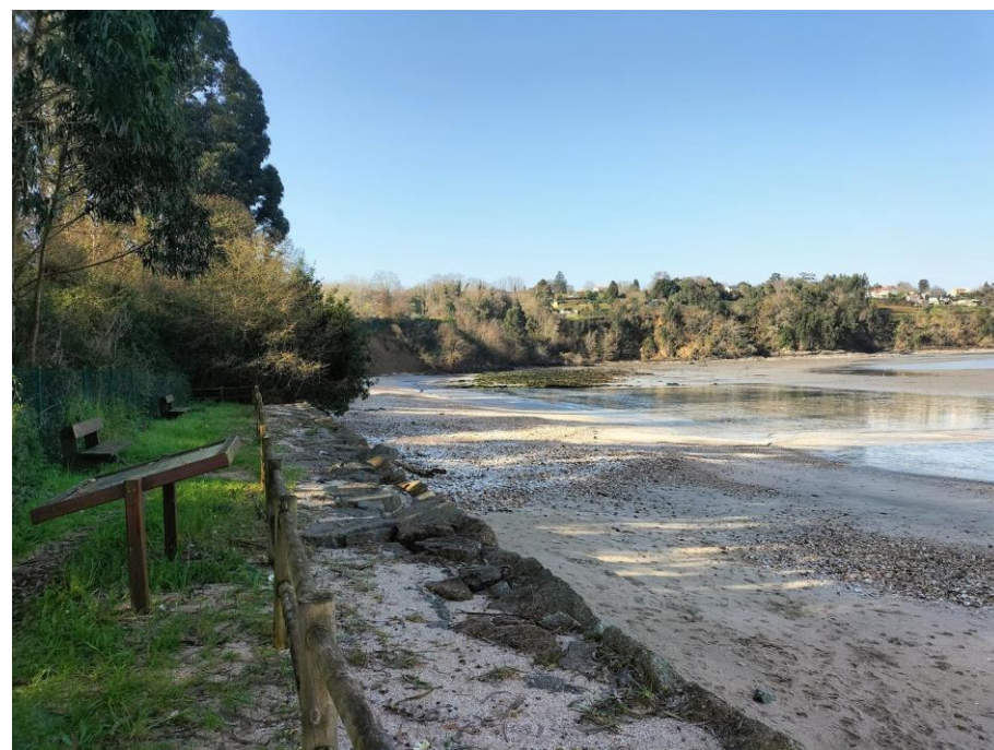
Fotografía nº10: Escollera de protección en la zona este de la playa do Regueiro
