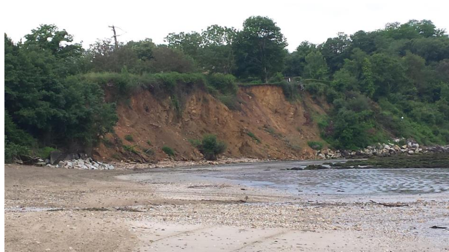
Fotografía nº20: Taludes en la zona oeste de la playa do Regueiro
