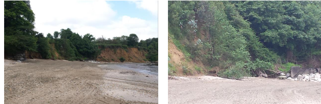
Zona Oeste sin acondicionar (objeto de actuación).
