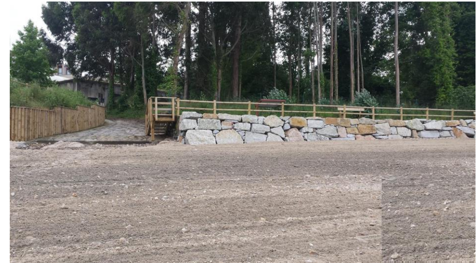
Fotografía nº11: Escollera de protección en la zona este de la playa do Regueiro
