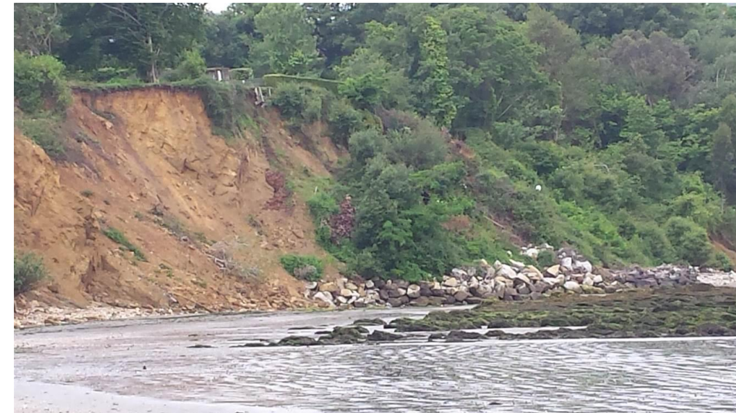
Protecciones puntuales existentes
