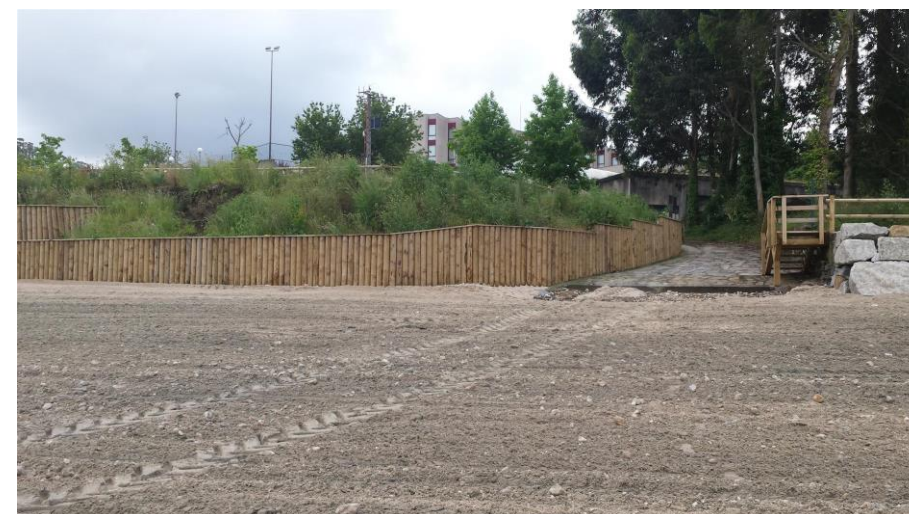
Fotografía nº8: Actuaciones de protección zona este de la playa do Regueiro
