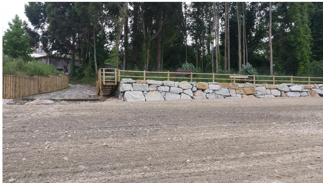
Actuaciones protección zona Este.
