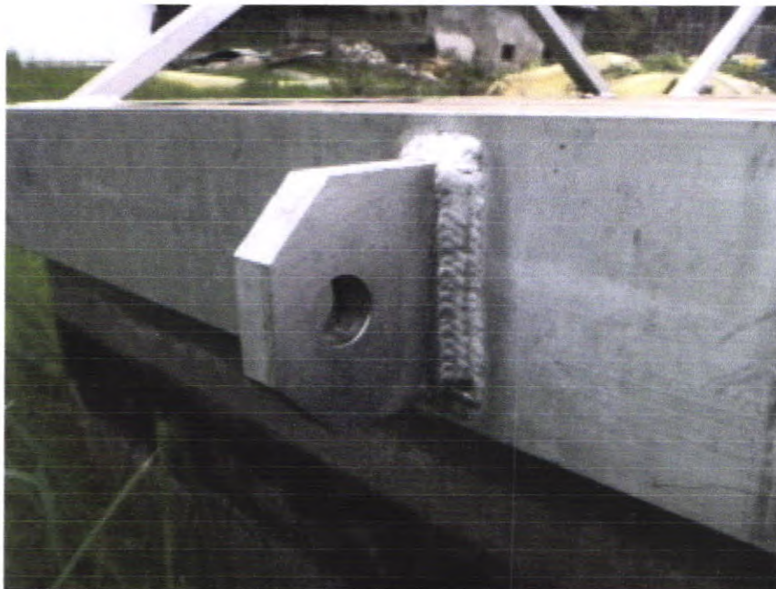
BISAGRA PARA UNIR LAS DOS PIEZAS DEL PANTALÁN
