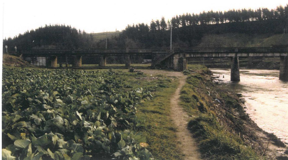
Puente reconstruido en 1958 – Tramo sobre ribera
