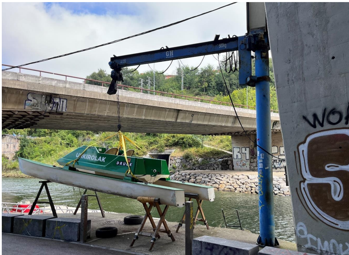
Figura 6. Puente grúa situado junto al pantalán en la margen izquierda del río Urumea
