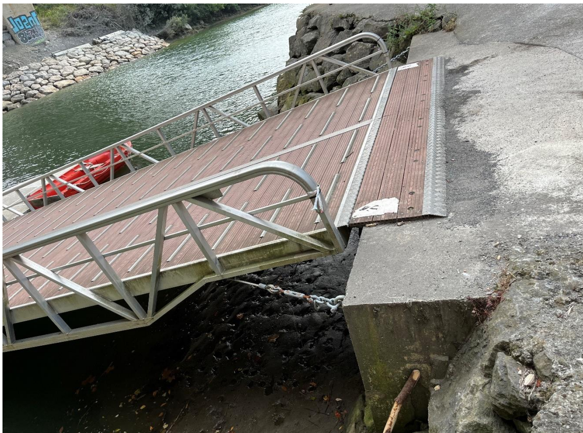
Figura 4. Apoyo de la pasarela en la viga cargadero de la margen izquierda y anclaje de los tirantes en ambos laterales
