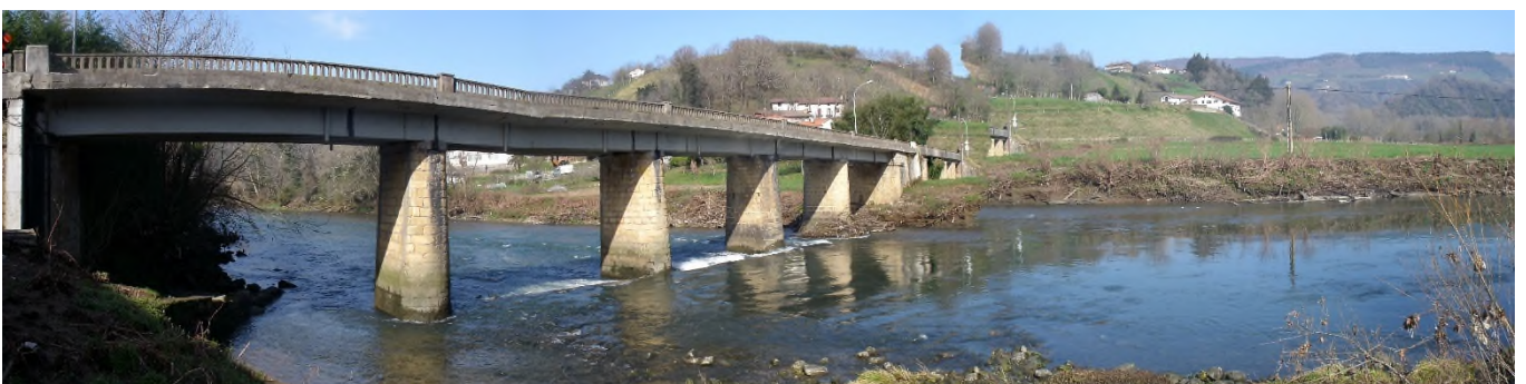
Figura 2. Vista desde aguas arriba del puente de Txokoalde
