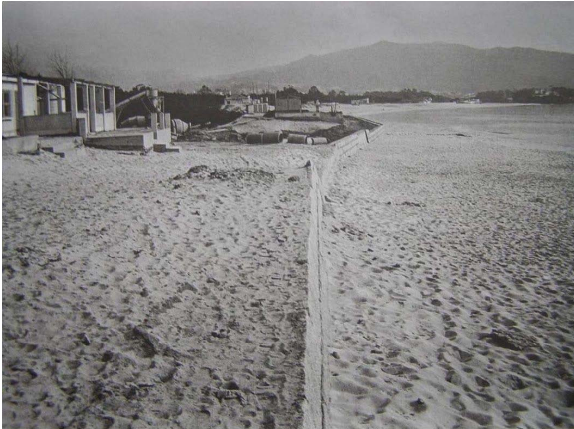
Fig. 3. Muro del paseo marítimo sobre la duna al final de su ejecución en 1971 - 72
