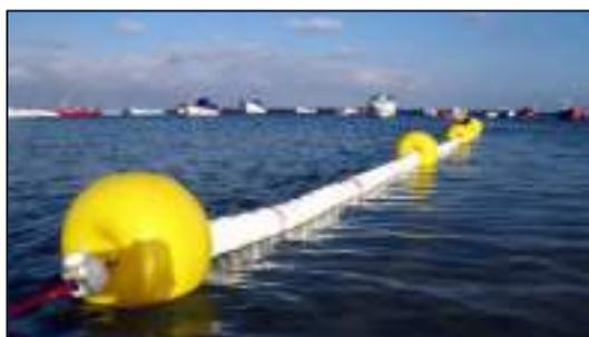
A continuación del canal de navegación, se ejecuta en su margen derecha una **zona de varada** para las embarcaciones náuticas con unas dimensiones de 100 x 65 m, en la que se dispone de una serie de bandas litorales (corcheras) para delimitar la zona.
