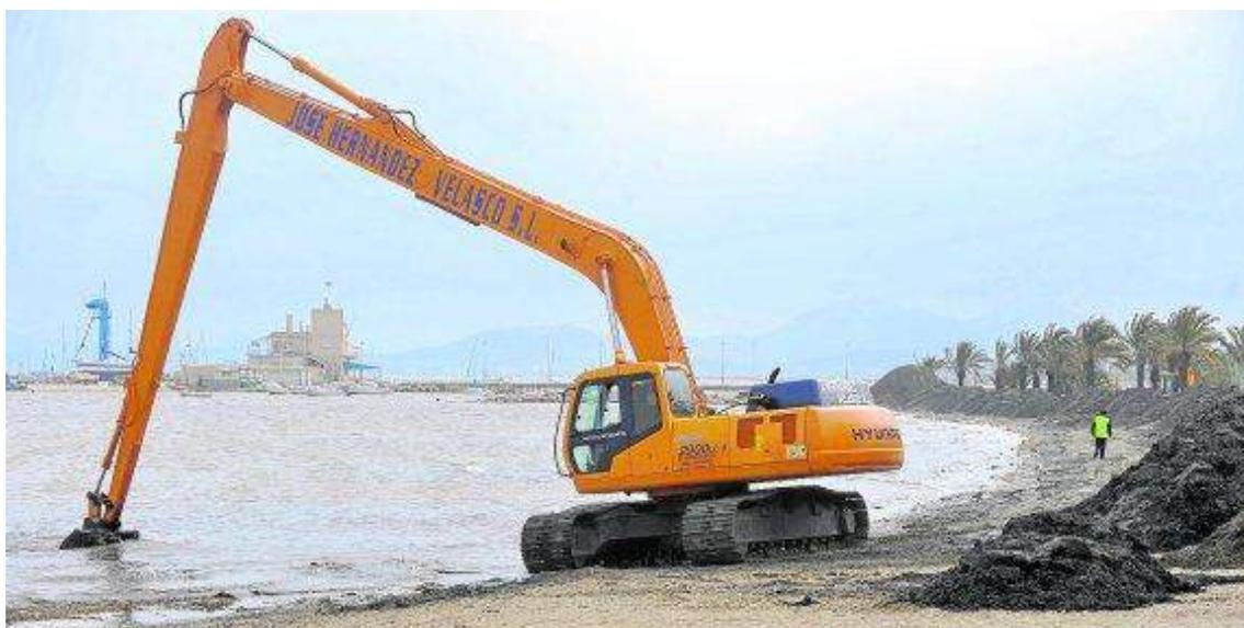
*Extracción de sedimentos con maquinaria pesada en 2003 en la zona de Los Urrutias*
