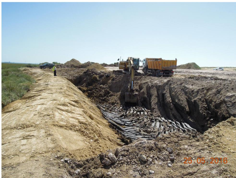
*Figura 19. Excavación del cajón de cimentación de la barrera de arcilla en la experiencia piloto realizada sobre un canal mareal de la Zona 2.*
