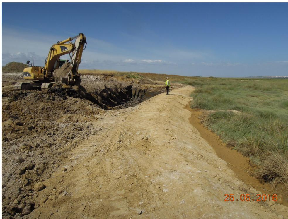
*Figura 20. Excavación del cajón de cimentación de la barrera de arcilla en la experiencia piloto realizada sobre un canal mareal de la Zona 2. A la derecha de la imagen se aprecia el dique de seguridad efectuado durante las obras.*
