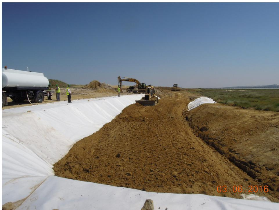
*Figura 21. Instalación de la barrera de sellado de arcilla sobre la protección de geotextil.*
