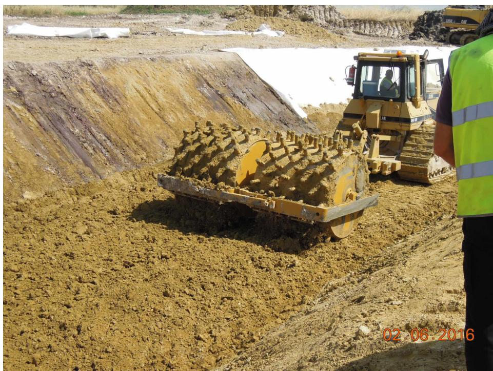
*Figura 22. Compactación de la barrera de sellado de arcilla en la experiencia piloto mediante humectación y compactadora de rodillo con pisones.*
