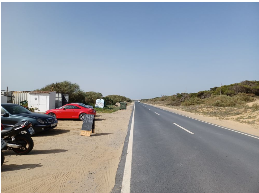
Aspecto de cordón en tramo adyacente
