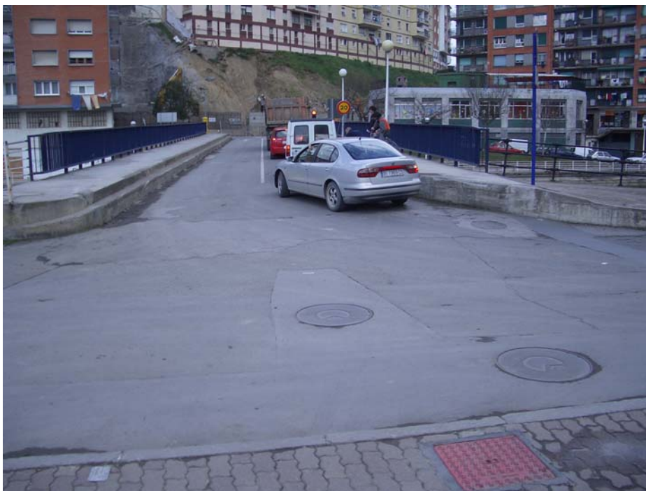
Fotografía nº 2. Vista superior desde la margen derecha: se aprecian las aceras sobreelevadas.
