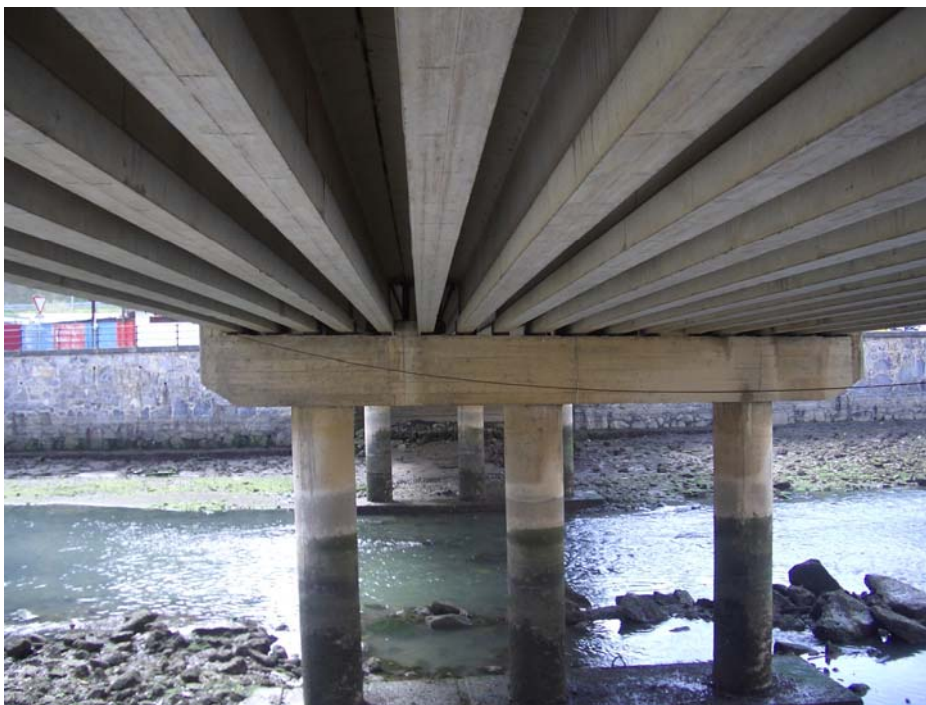
Fotografía nº 4. Vista inferior del tablero desde el paso peatonal de la margen izquierda. Se ve la formación del tablero con vigas prefabricadas.
