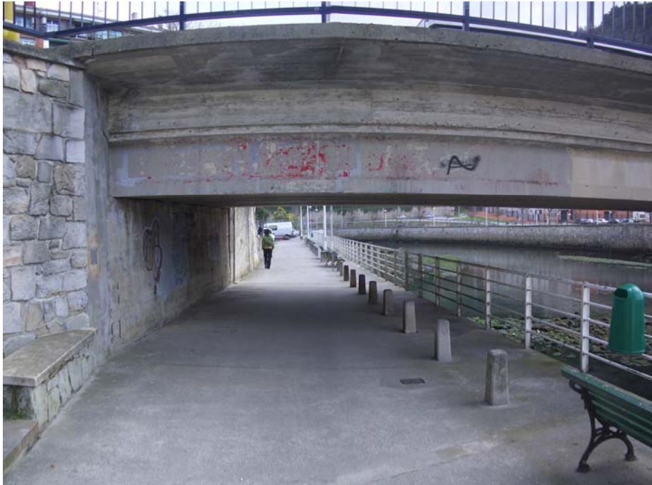
Fotografía nº 5. Vista del paso inferior peatonal bajo el puente Zaldupe en la margen izquierda.
