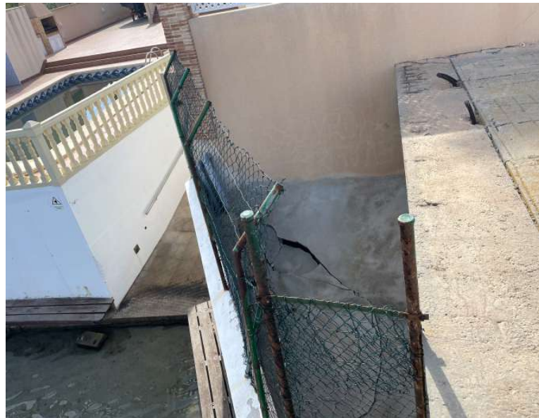
Figura 16. Esquina vallada de margen izquierda.
