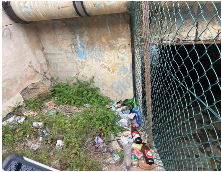
Figura 11. Zona de acopio de basura.
