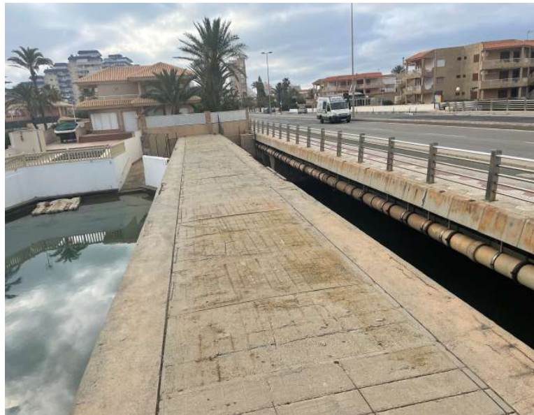
Figura 4. Vista superior desde escaleras de acceso margen derecha.
