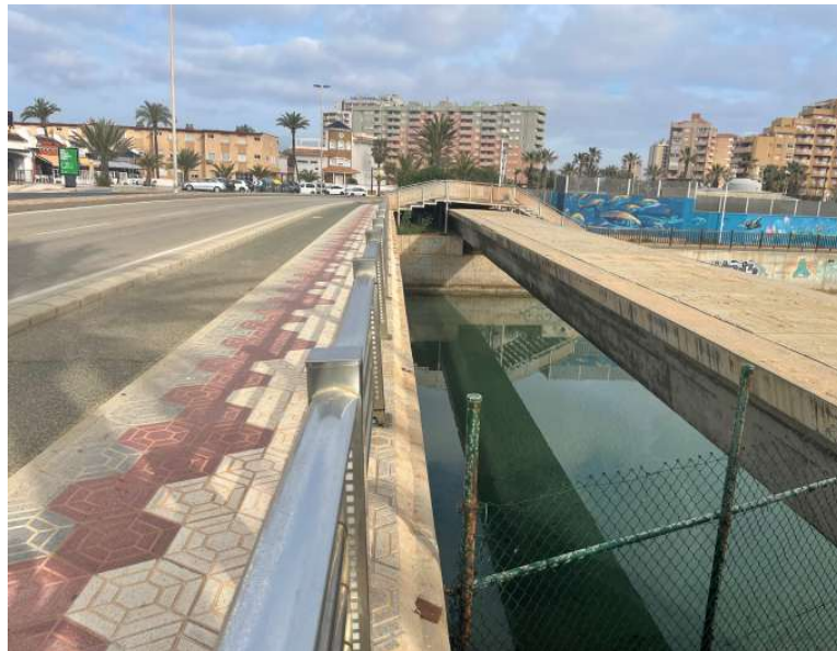
Figura 8. Vista desde Gran Vía de la Manga margen izquierda.
