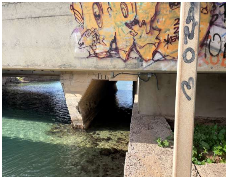
Figura 20. Pilar deteriorado.
