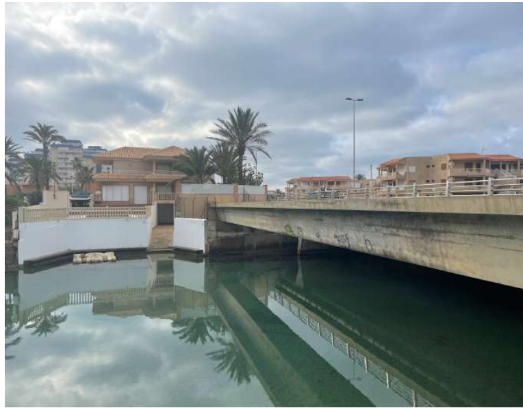
Figura 3. Vista desde escaleras de acceso margen derecha.
