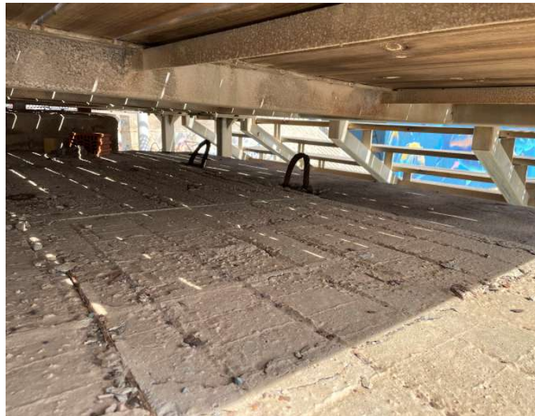
Figura 18. Hueco bajo escaleras de acceso margen derecha.
