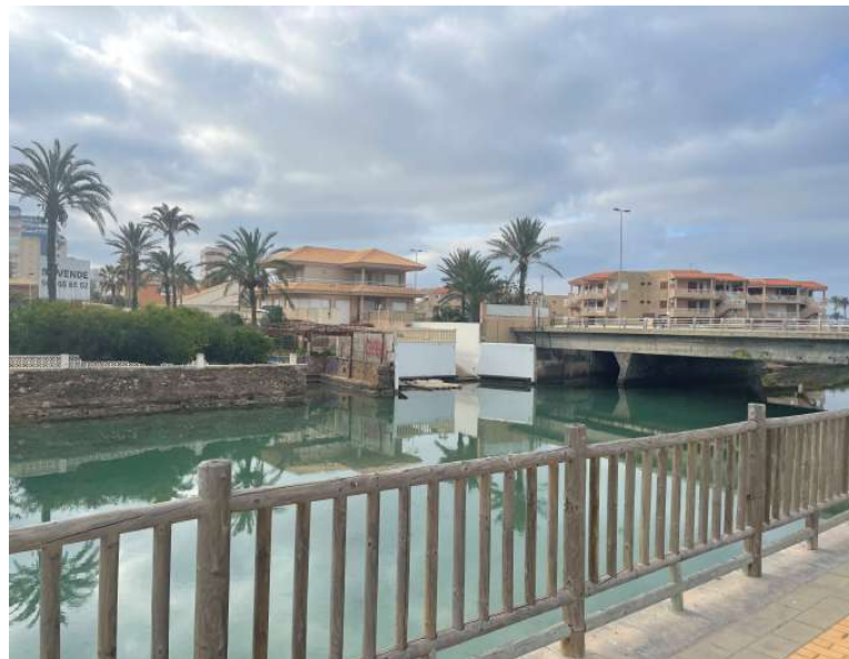
Figura 2. Vista desde margen derecha.
