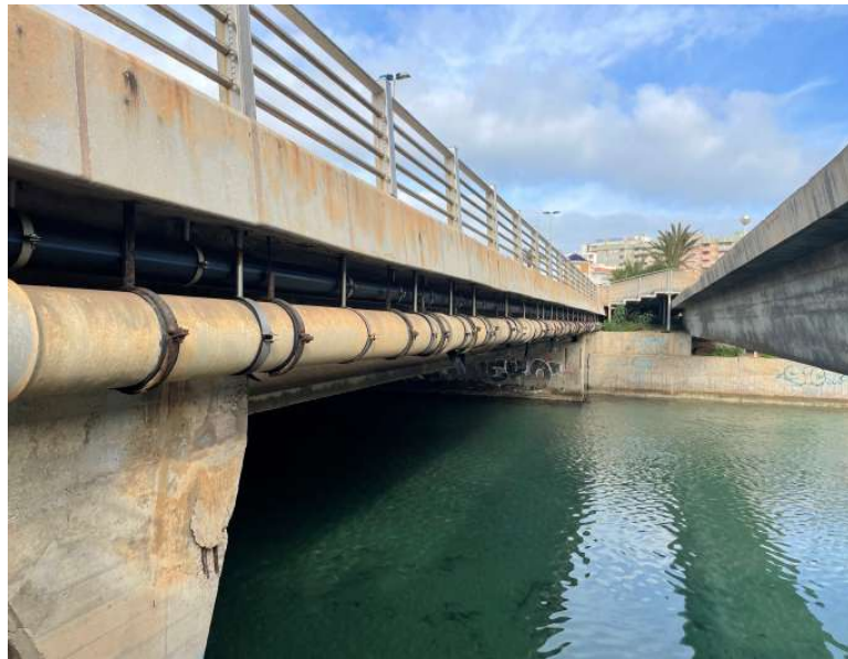
Figura 10. Vista de ferralla al descubierto margen izquierda.
