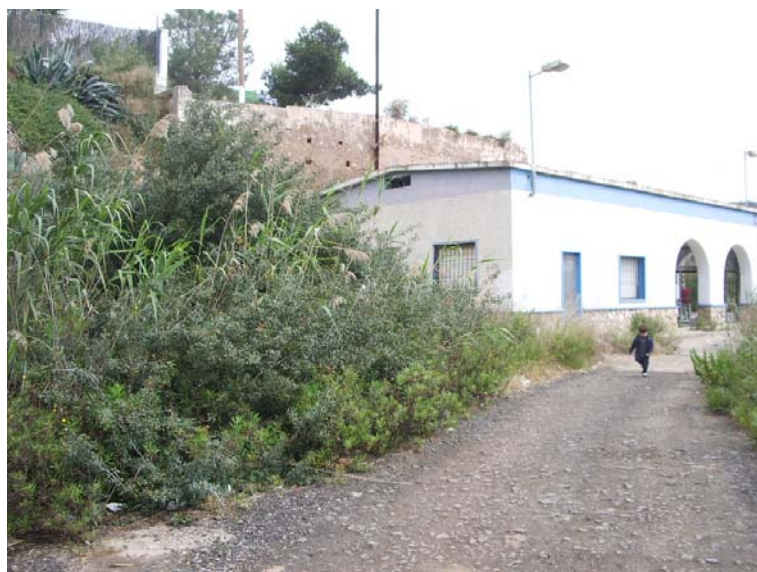
Foto 6: Vista posterior de Edificio nº 2
