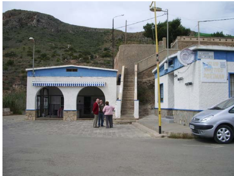
Foto 3: Vista accesos Edificio nº 1 y Edificios nº 2
