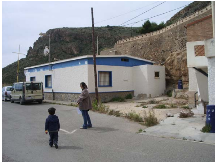
Foto 5: Vista posterior de Edificio nº 1
