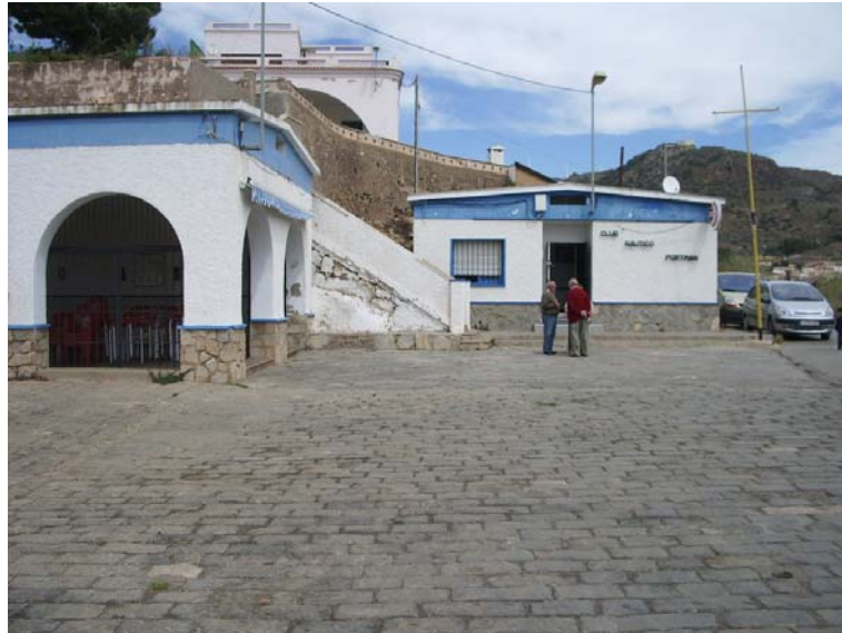
Foto 1: Vista frontal Edificio nº 1
