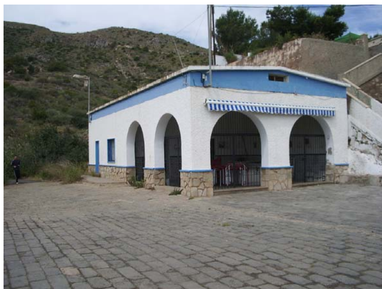
Foto 2: Vista frontal Edificio nº 2
