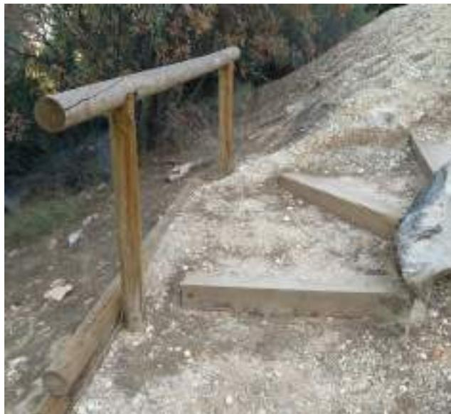
Figura 15. Ejemplo de escalones con traviesas de madera en el Parque Regional de Sierra Espuña
