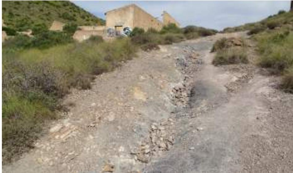
Figura 29. Tramo 1 deteriorado por las escorrentías en períodos de lluvia.
