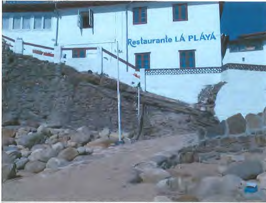
FOTO 5.- Arranque del muro sobre el que se asientan las escaleras adosadas a la fachada Este.
