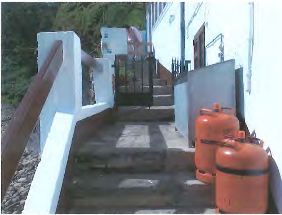
FOTO 2.- Escaleras adosadas a la fachada Este de la vivienda.
