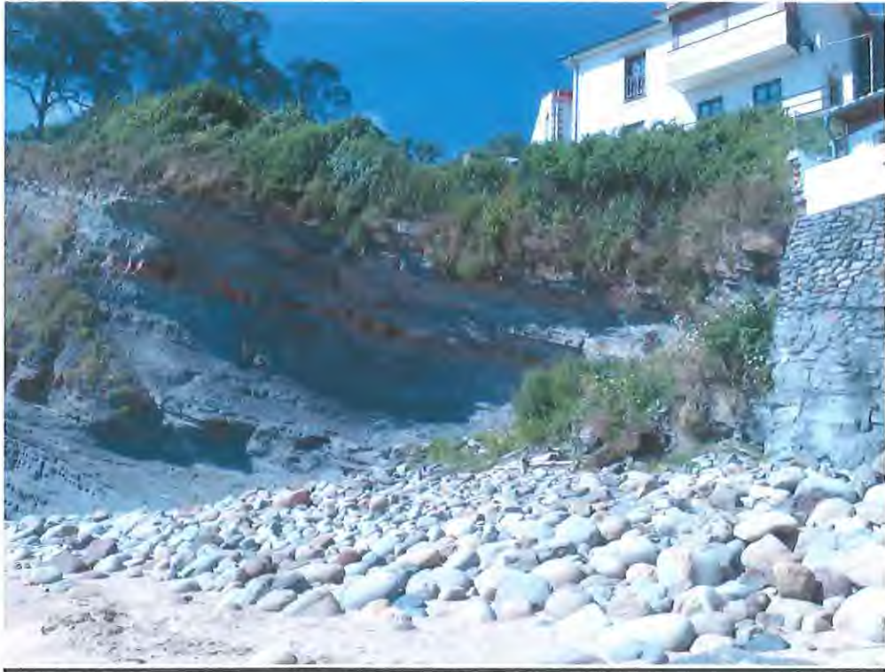
FOTO 7.- Escarpe existente al final (Sureste) del precitado muro.
