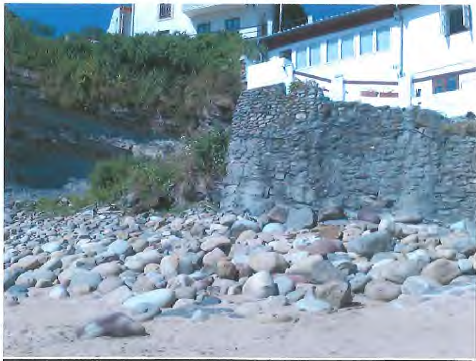
FOTO 6.- Final del muro anterior.
