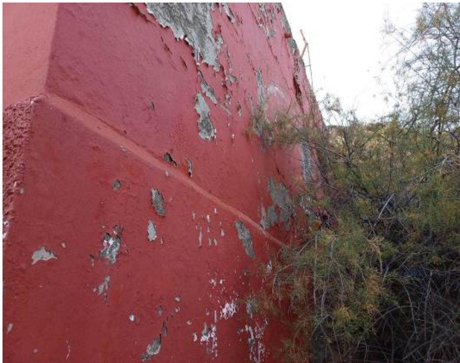
Parte trasera de la vivienda.
